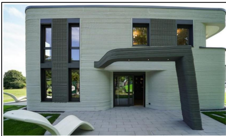
Slika 30. Kuća izgrađena pomoću aditivne tehnologije [33]
