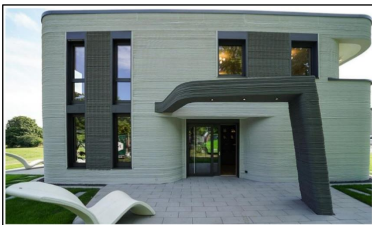
Slika 30. Kuća izgrađena pomoću aditivne tehnologije [33]
