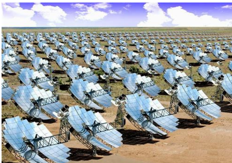
Slika 22. Prva solarna elektrana sa Stirlingovim motorima u Dubaiju [66]
