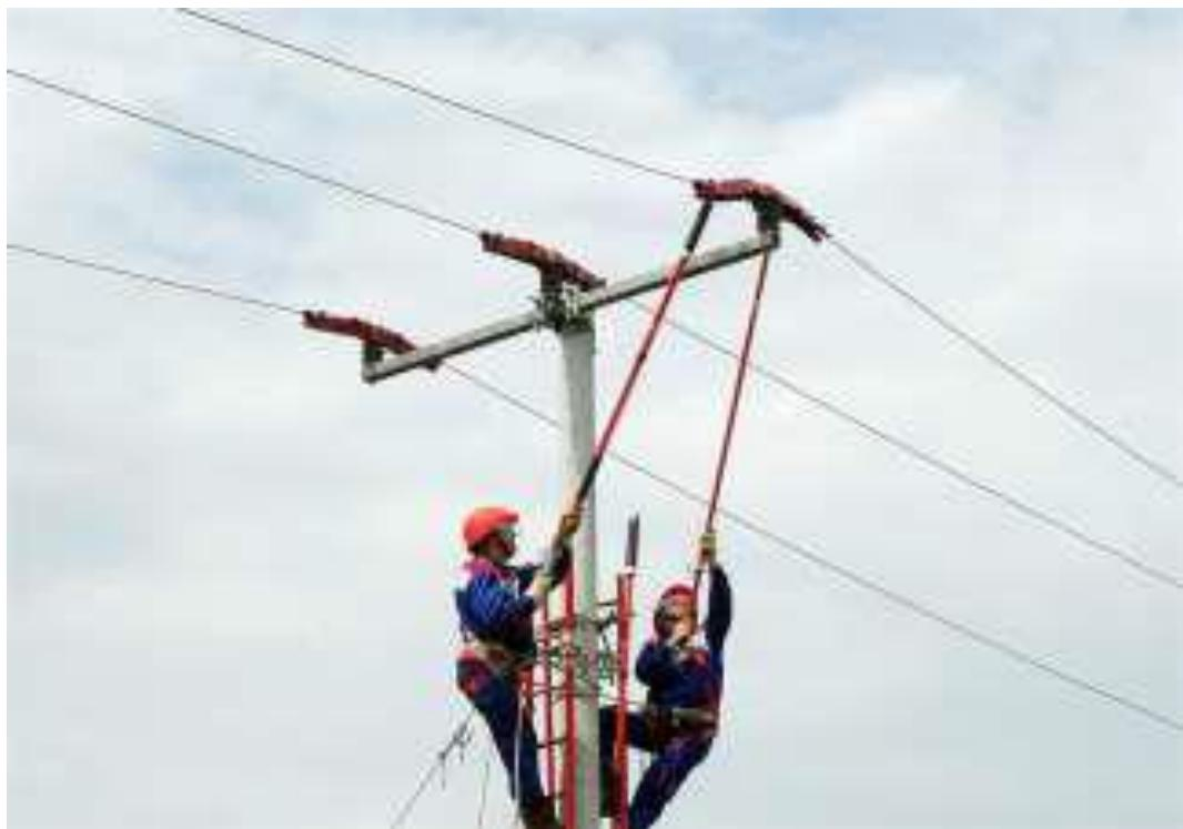
Slika 15. Postavljanje zaštite od ptica na SN vod [17]
