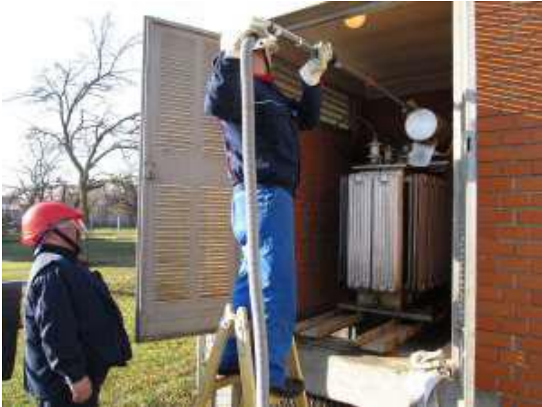
Slika 14. Čišćenje SN/NN kablanske trafostanice pod naponom industrijskim usisivačem [17]
