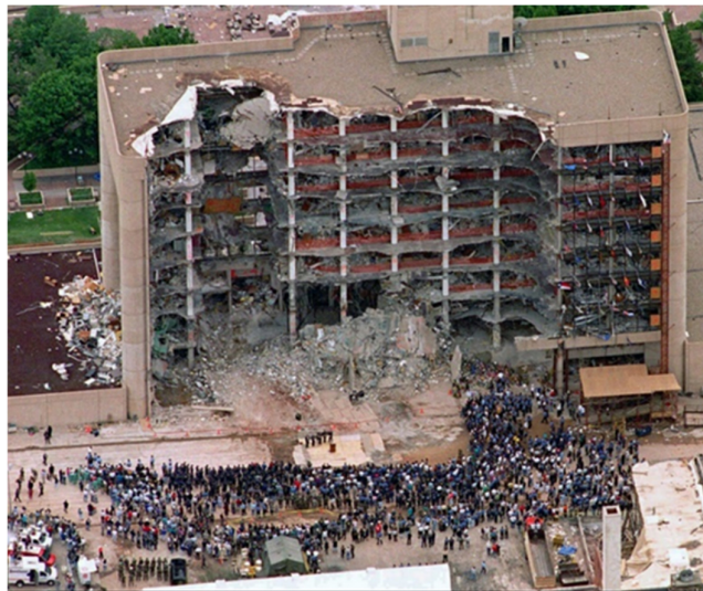
Sl.br.2 Federalna zgrada Alfreda P. Murraha nakon bombardiranja
