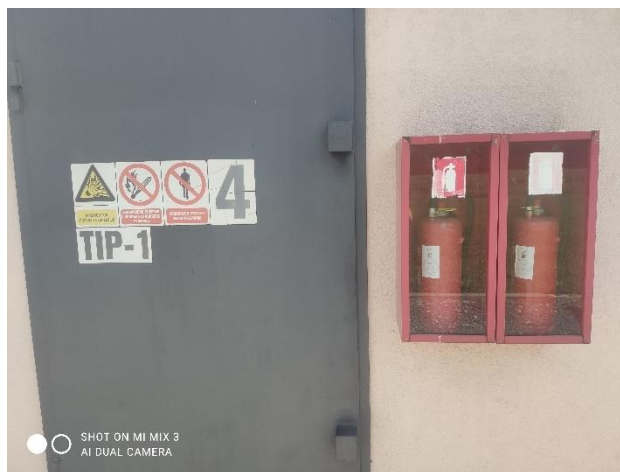
Slika 31. Položaj vatrogasnih aparata za početno gašenje požara [25]
