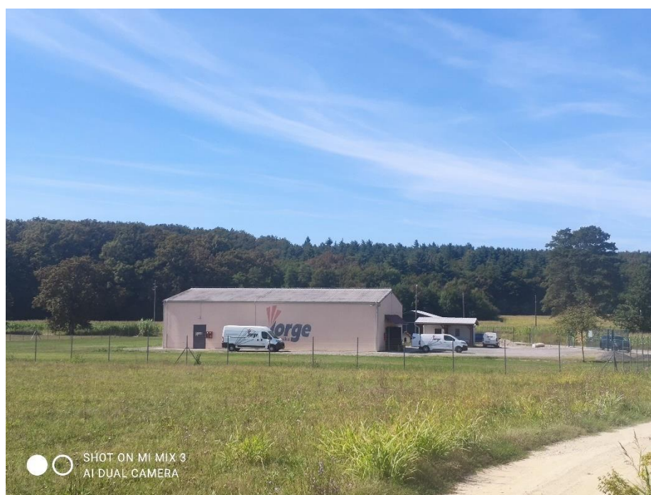
Slika 29. Ograda oko skladišta [25]
