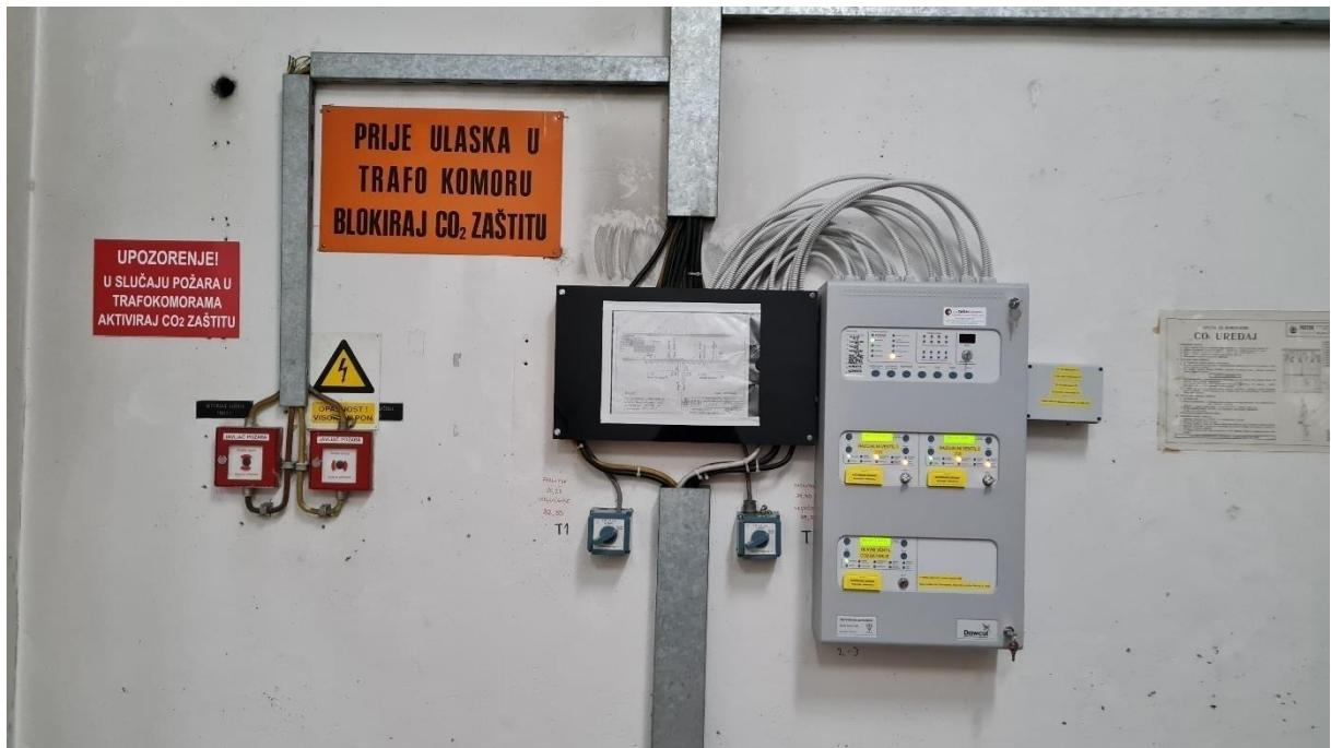
Slika 7. Elektro dio sustava gašenja požara plinom CO<sub>2</sub> [9]
