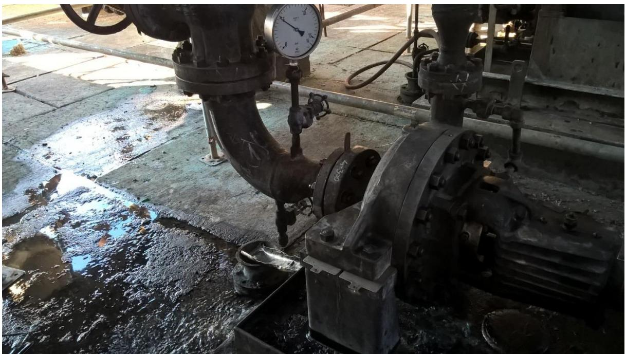
Slika 7. Pumpa ukapljenog naftnog plina 321 MP-012A sa mjestom požara [4]
