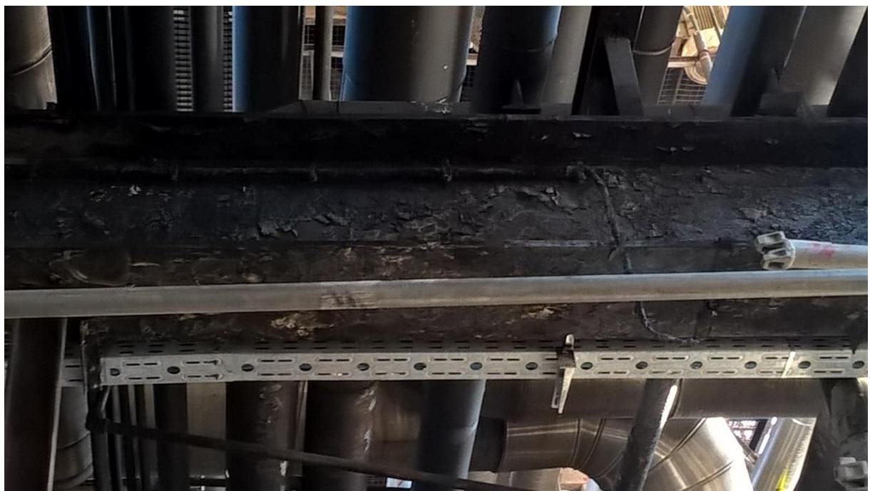
Slika 9. Mesta na konstrukciji koje je zahvatio požar – izolacija [4]
