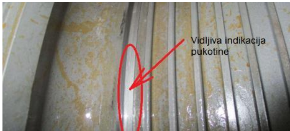
Slika 51. Postojanje pukotine nakon drugog koraka
