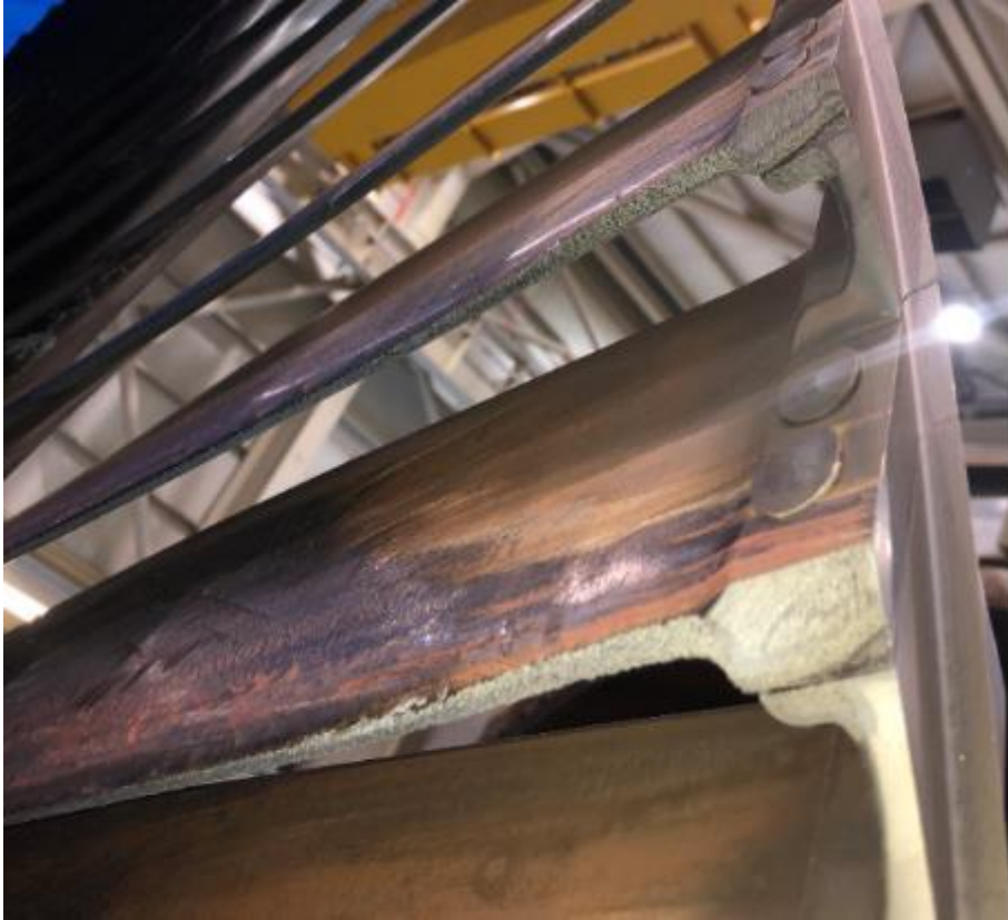
Slika 36. Erozija na zadnjem redu lopatica niskotlačnog rotora
