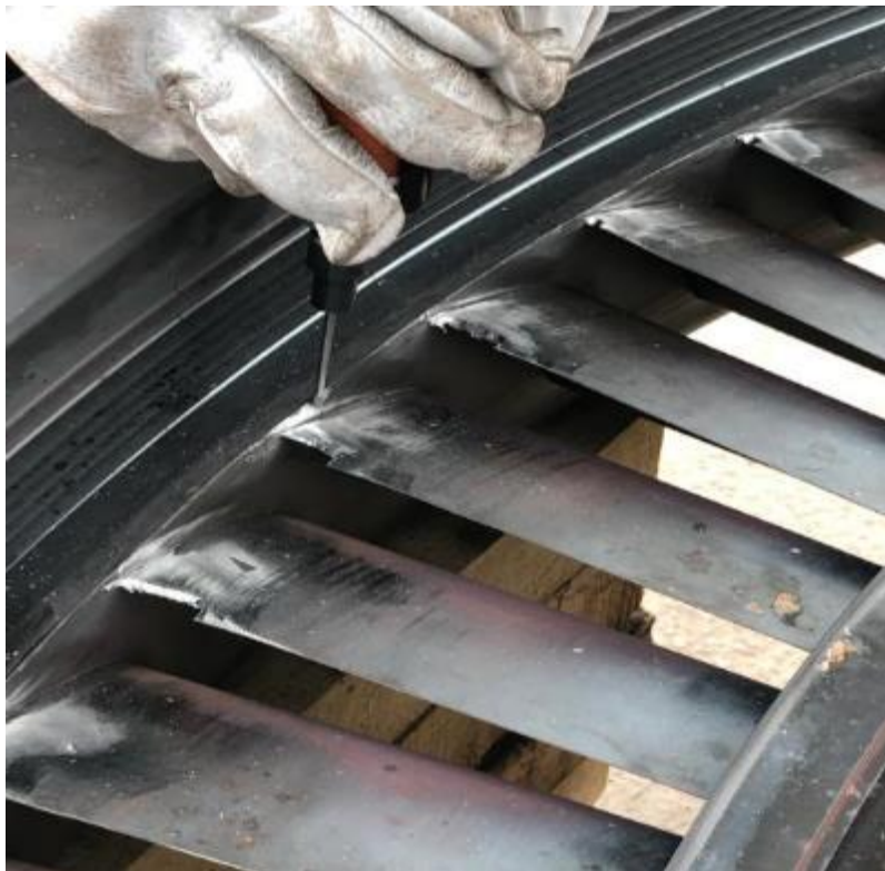
Slika 27. Izrezivanje oštećenih dijelova
