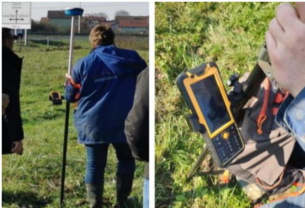
Slika 32. Određivanja trase VT plinovoda
