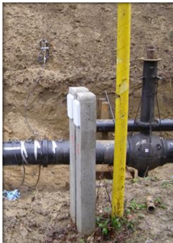
Slika 19. Mjerno mjesto sustava katodne zaštite
