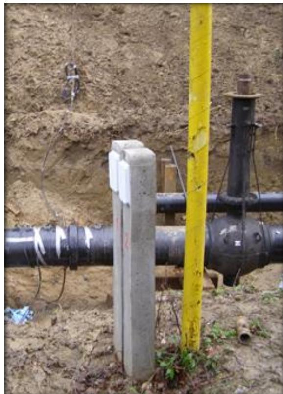
Slika 19. Mjerno mjesto sustava katodne zaštite
