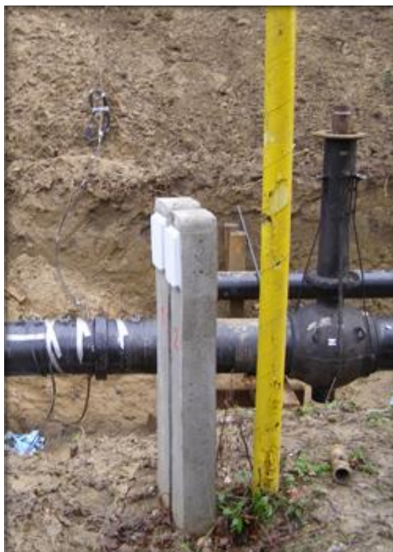
Slika 19. Mjerno mjesto sustava katodne zaštite
