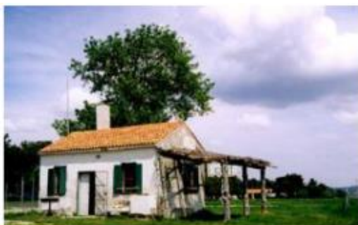
Slika 16. NADZORNA KUĆICA NA CRKVINAMA
