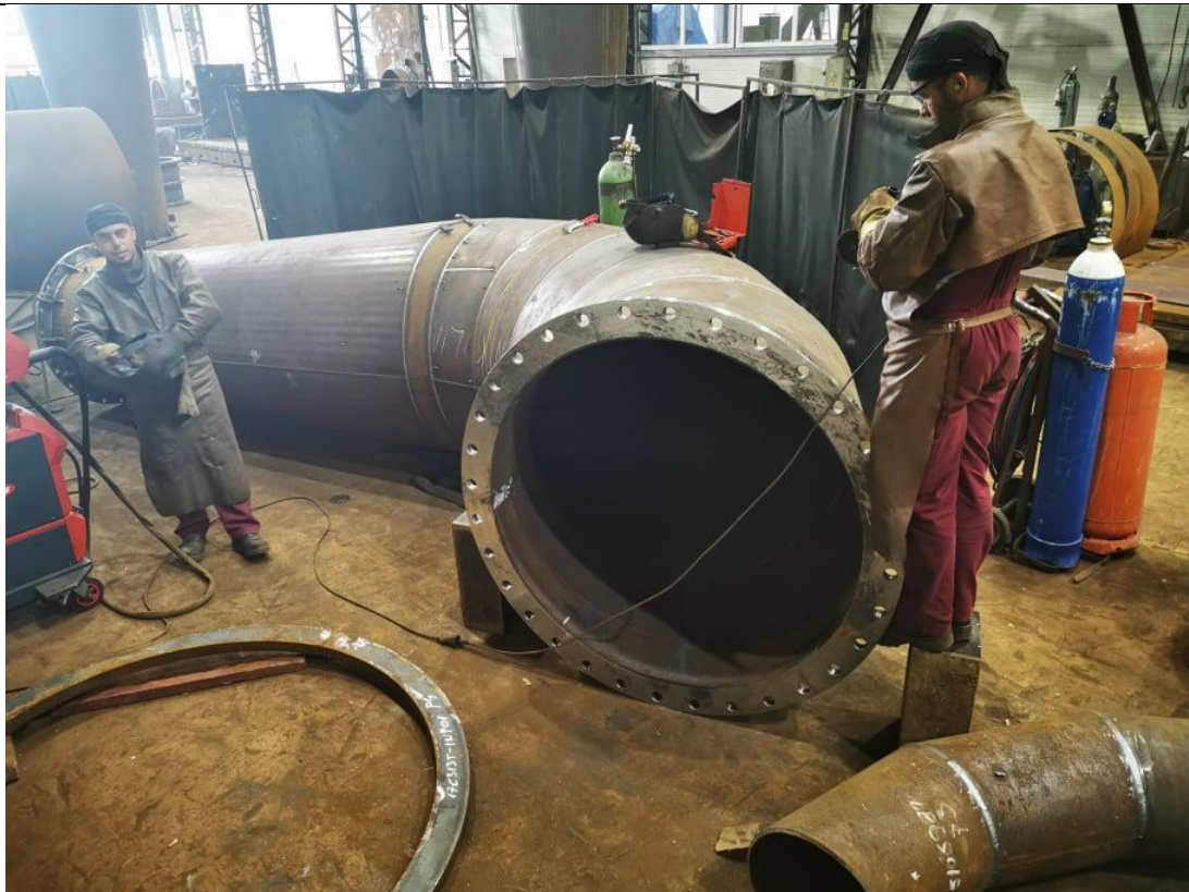
Slika 14.3 Kompletno bravarski složena pozicija na zavarivanju.
