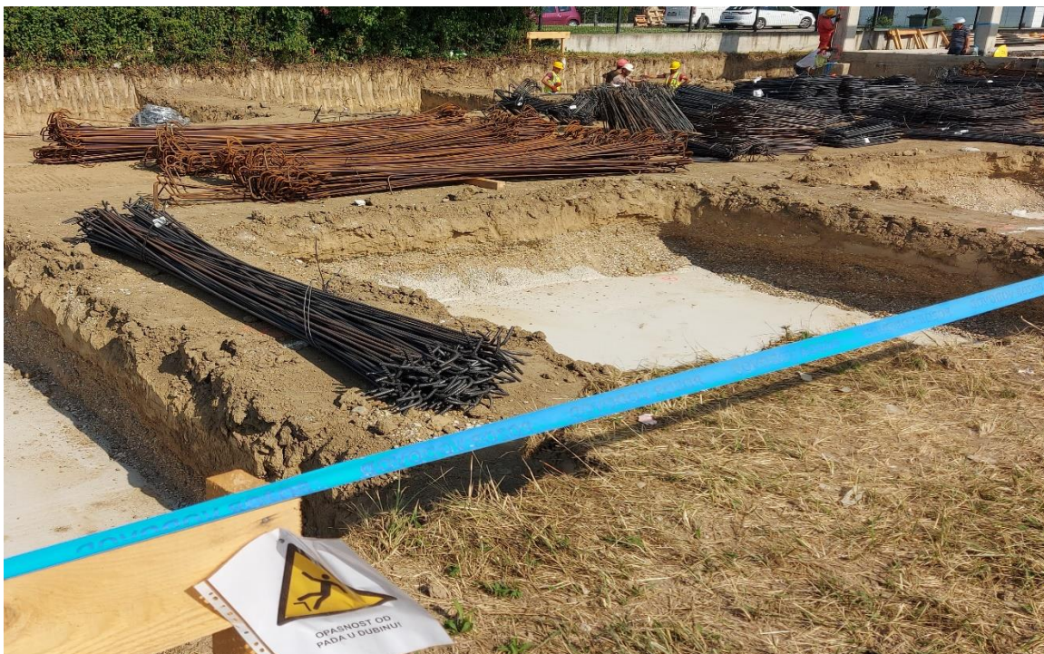
Slika 4. Materijal pripremljen za ugradnju
