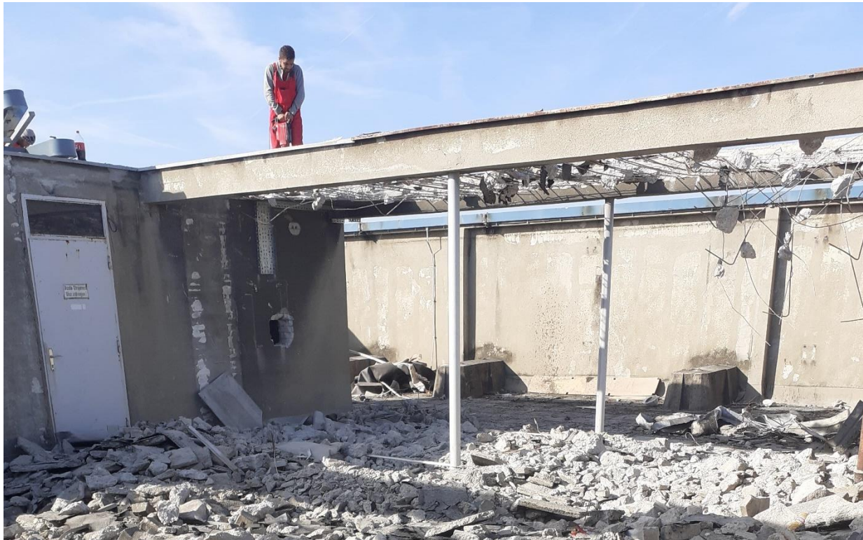
Slika 22. Radnik stoji na napola napukloj armaturi tijekom rušenja
