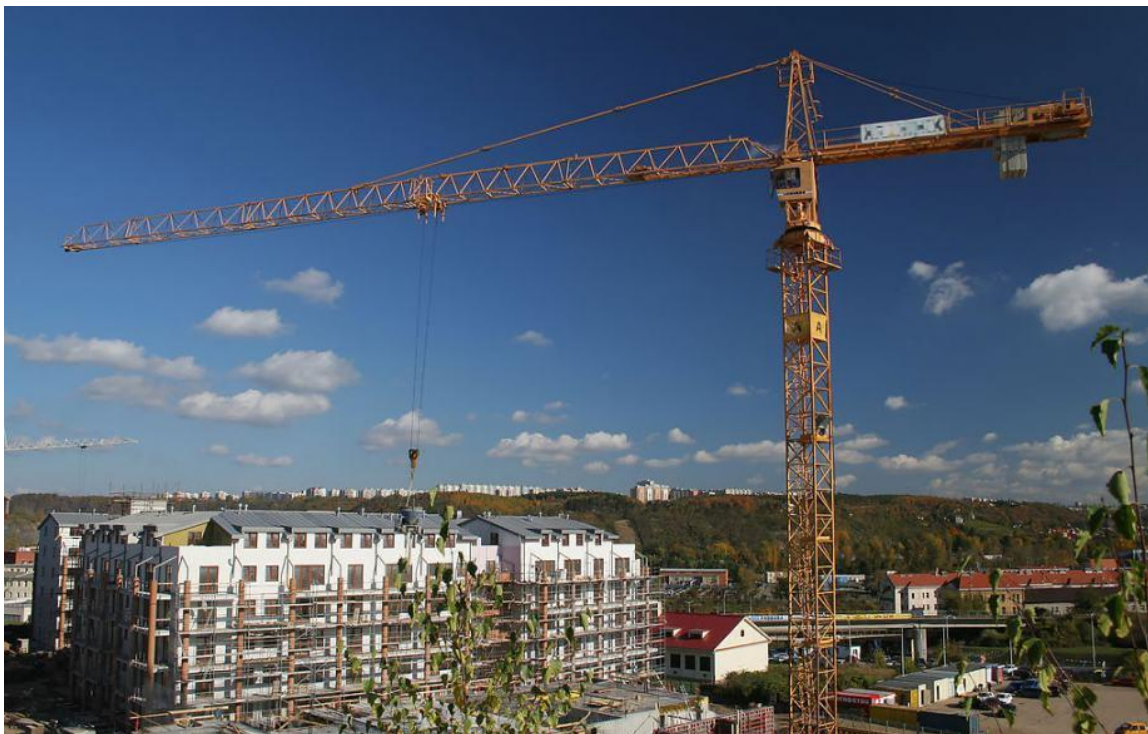
Slika 12. Kran koji svojom veličinom pokriva cijelo gradilište
