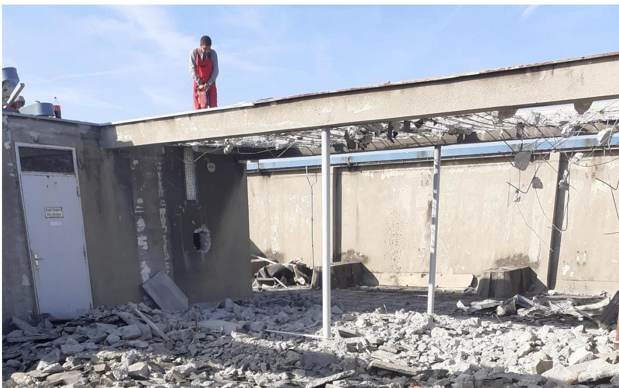
*Slika 22. Radnik stoji na napukloj armaturi tijekom rušenja*
