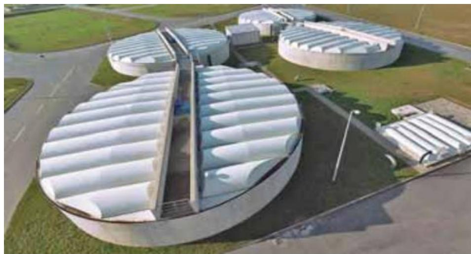
**Slika 16.** Prethodni i naknadni zgušnjivači mulja [11]
