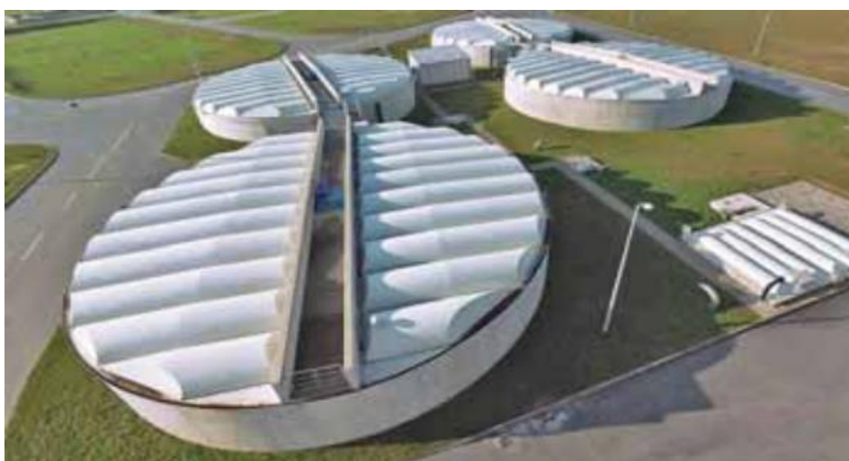
Slika 16. Prethodni i naknadni zgušnjivači mulja [11]
