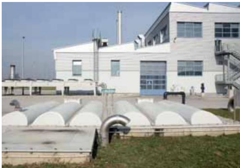
Slika 17. Spremnici viška mulja [11]
