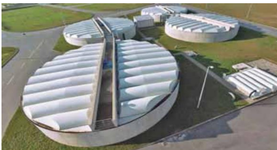
Slika 16. Prethodni i naknadni zgušnjivači mulja [11]
