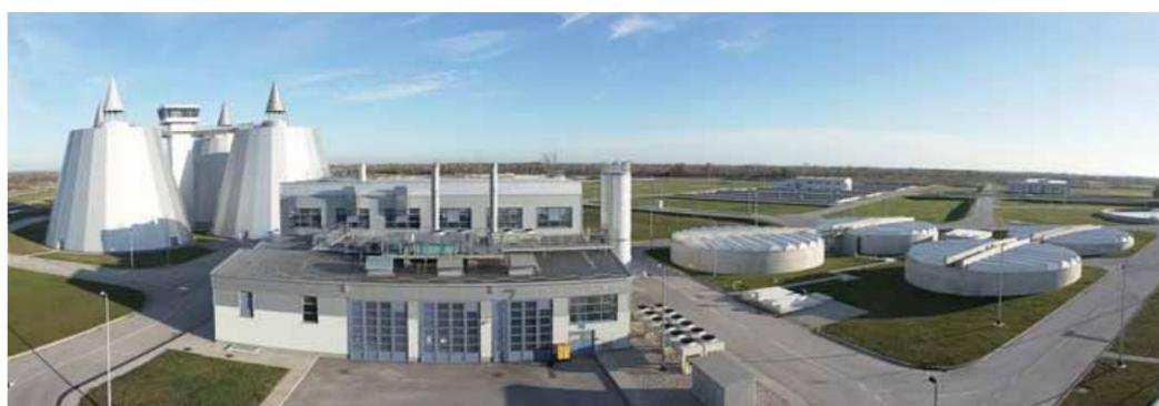
**Slika 14.** Objekti za obradu mulja [11]
