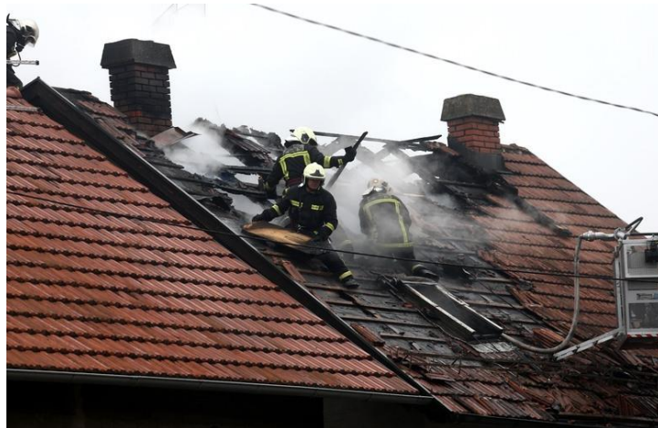
Slika 6. Gašenje drvene konstrukcije krova [10]
