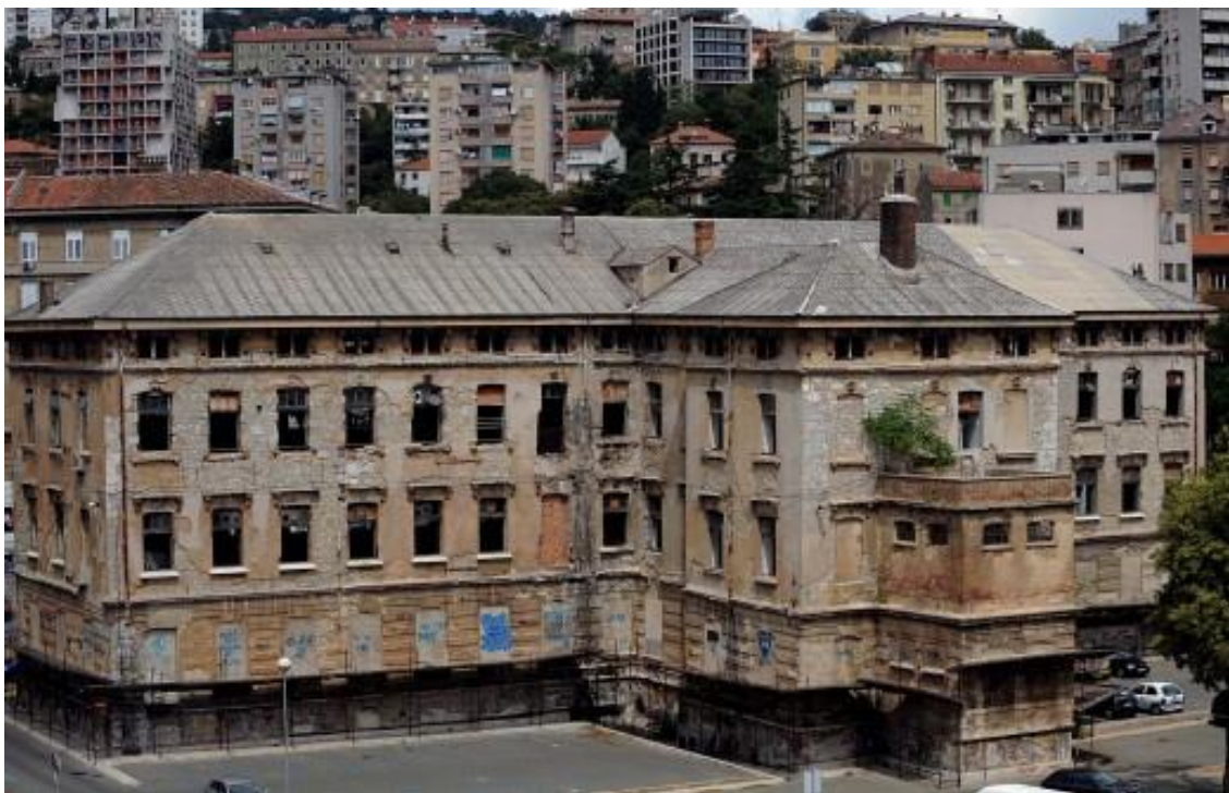
Slika 15. T - objekt prije rekonstrukcije [30]
