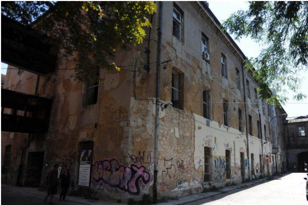
Slika 10. H-objekt prije rekonstrukcije[19]
