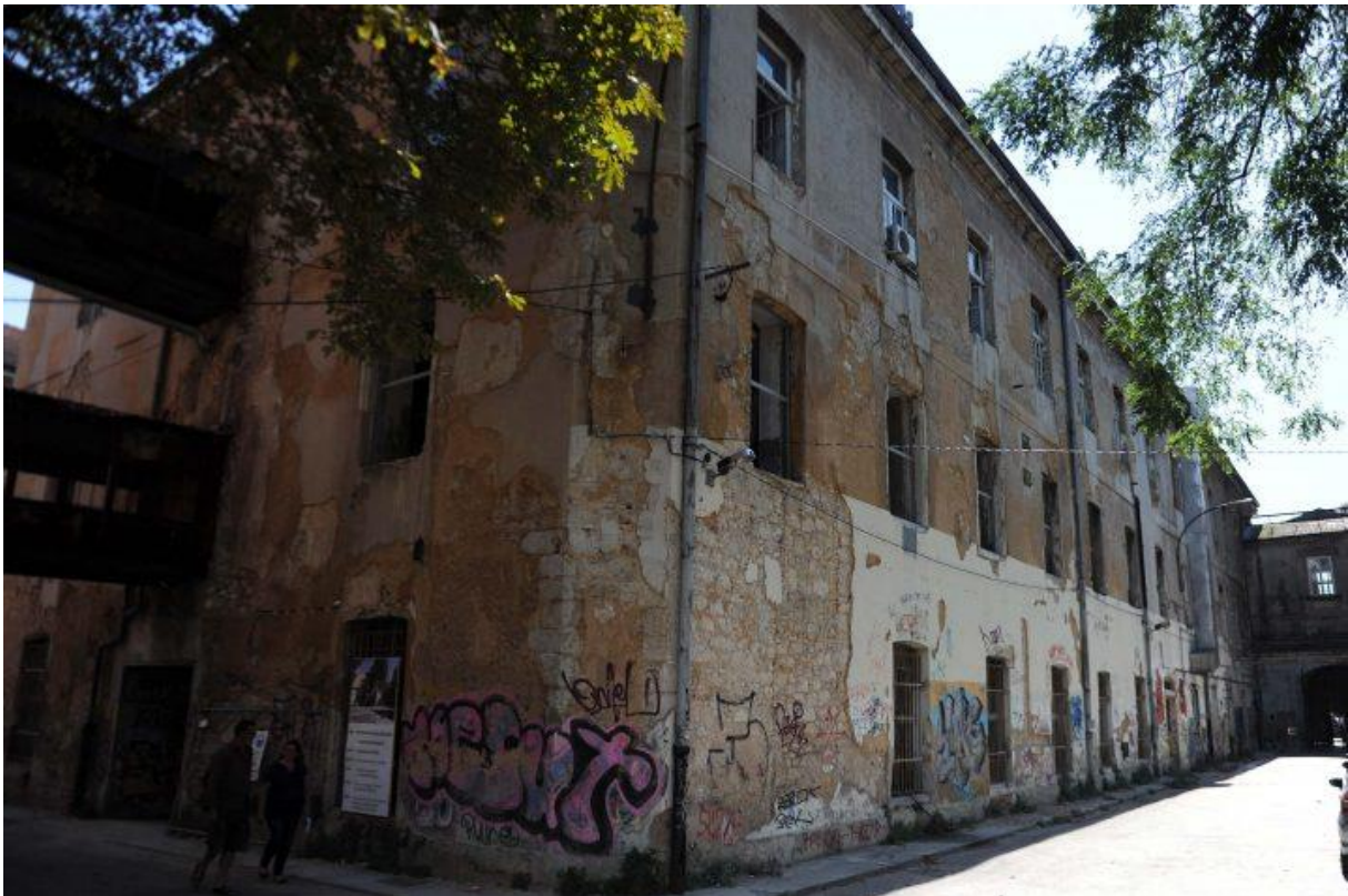
Slika 10. H-objekt prije rekonstrukcije[19]
