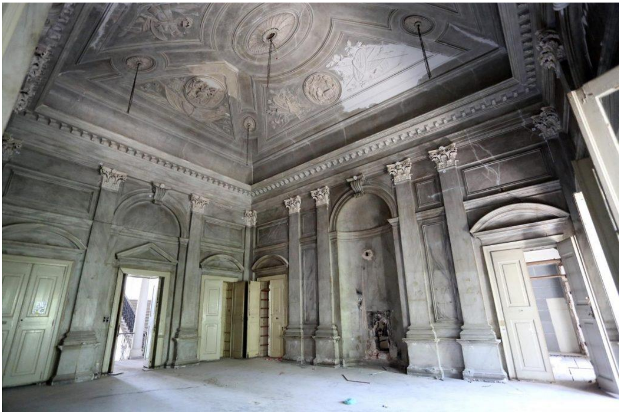
Slika 7. unutrašnjost palače prije restauracije [13]
