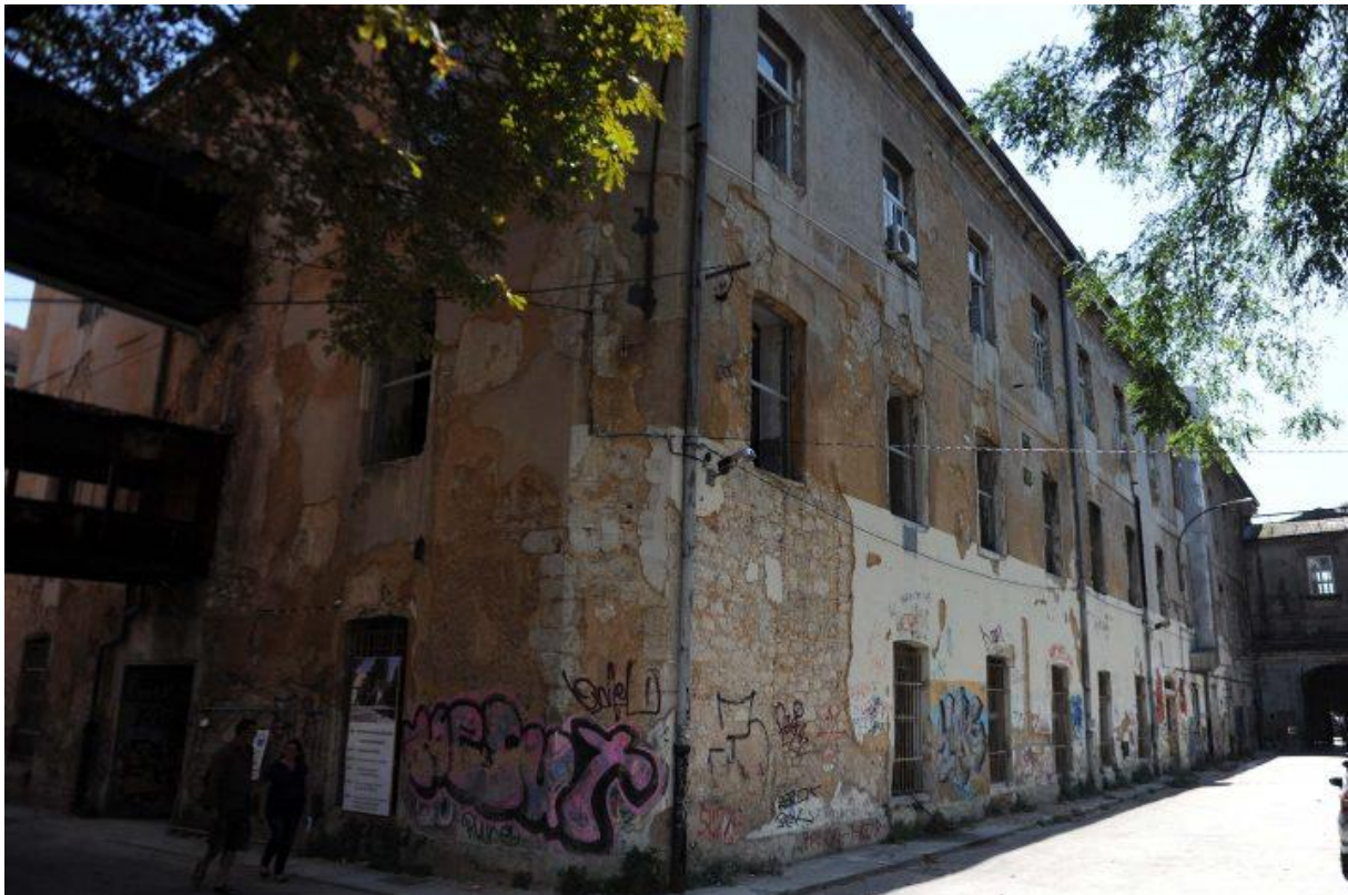
Slika 10. H-objekt prije rekonstrukcije[19]
