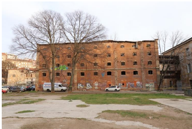
Slika 12. Ciglenu zgradu prije rekonstrukcije [24]
