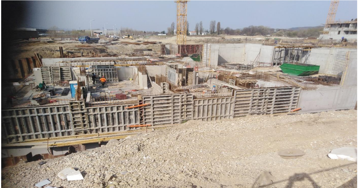
Slika 9: Početak gradnje nadzemnog dijela
