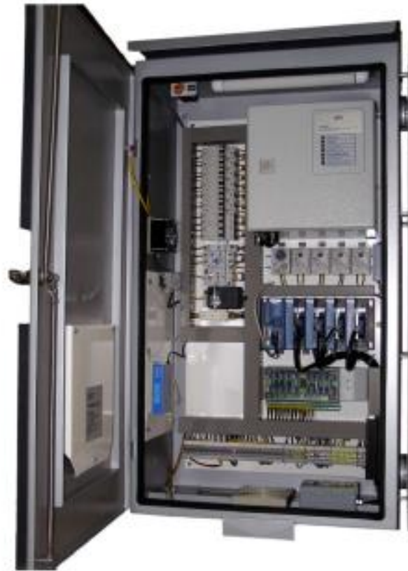
Ilustracija 9. Ormar informacijskog sustava motrenja
