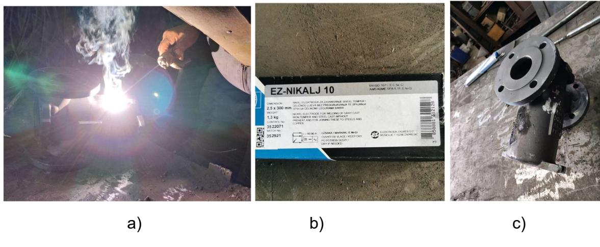
Slika 30. a) zavarivanje pukotine na zagrijanom odljevku ; b) elektroda kojom se vrši zavarivanje c) zavarena pukotina na odljevku
