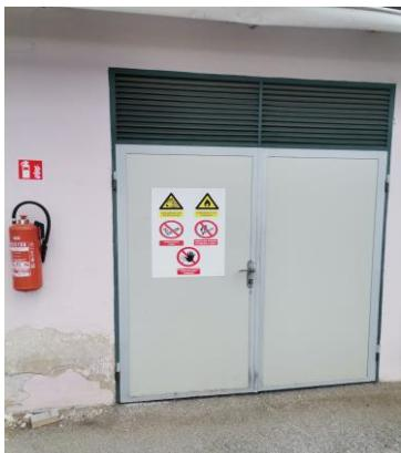
Skladištenje opasnog otpada je vrlo važno zbog opasnosti koje te supstance izazivaju, njihova isparavanja, izljevanje i samozapaljenje. Zato postaju posebne hale koje su odvojene od pogona i koje udovoljavaju klimatskim uvjetima pri kojima se ne može doći do katastrofe. I sami pod je izoliran plastičnim slojem koji štiti od izljevanja i istjecanja stranog tijela, koji prirodi i samim ljudima može uzrokovati stvarne probleme.
