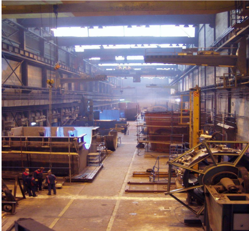
Slika 5: Hala 2 dimenzija 20×165 m, max nosivost najveće dizalice u hali 600 kN
