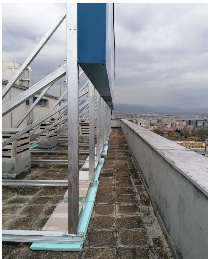
Slika 21. Spuštena reklama na krovu
