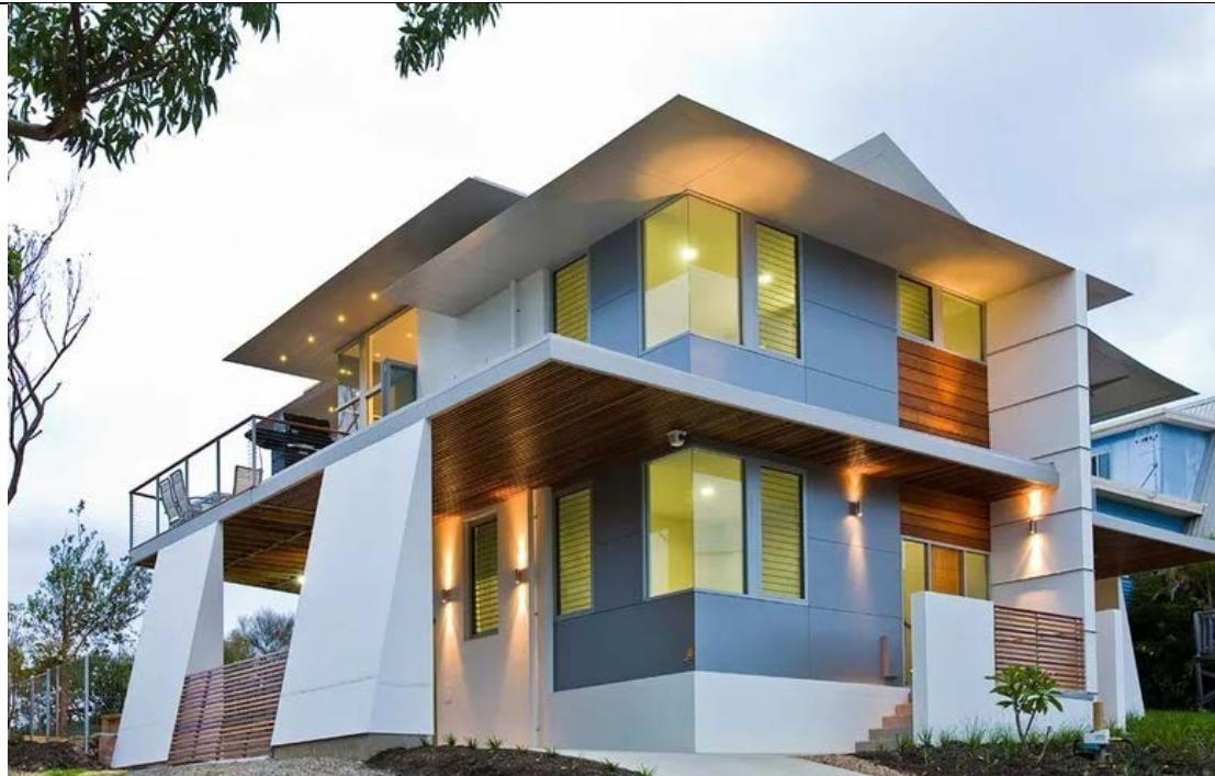
**Slika 2. Primjer alucobond ventilirajuće fasade [4]**
