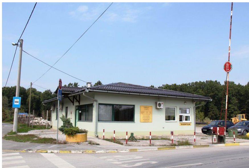
Slika 8. Upravna zgrada odlagališta.
