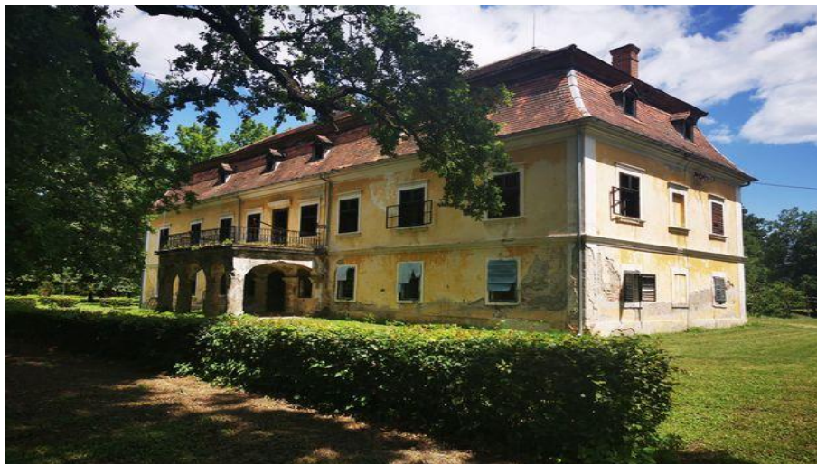
Slika 11 Trenkov dvorac u Trenkovu
