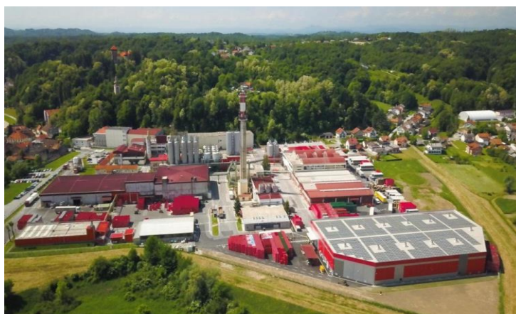
Slika 6. Heineken Hrvatska d.o.o. u Karlovcu
