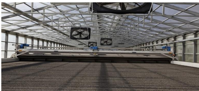
Slika 13. Solarno sušenje mulja
