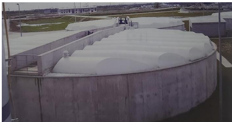
Slika 8. Pokriveni gravitacijski zgušnjivač mulja [8]
