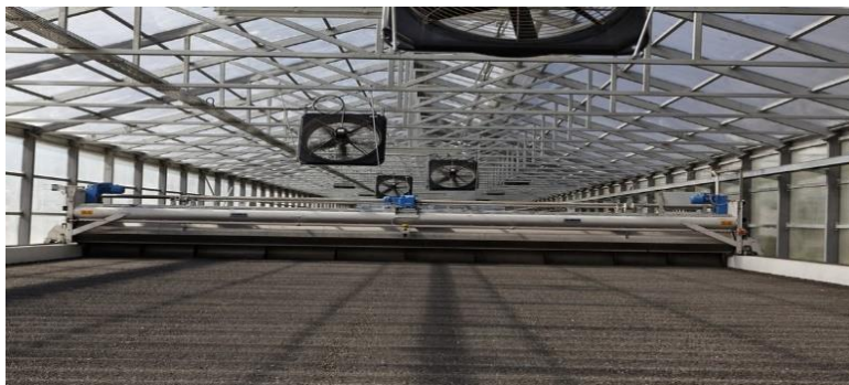
Slika 13. Solarno sušenje mulja
