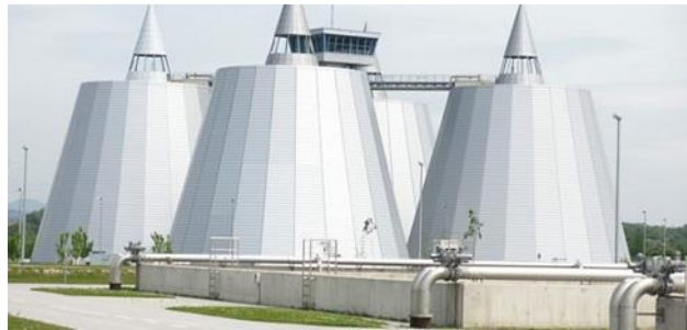
Slika 9. Tornjevi anaerobne obrade mulja na uređaju za pročišćavanje [8]
