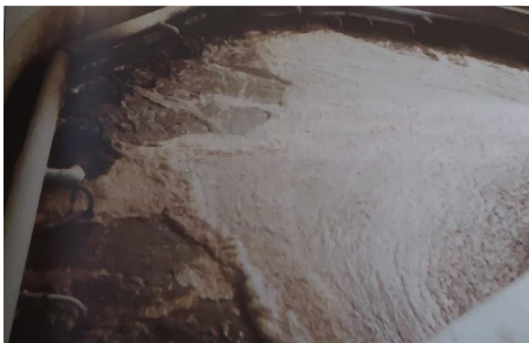
Slika 10. Aerobna stabilizacija mulja na uređaju za pročišćavanje [8]
