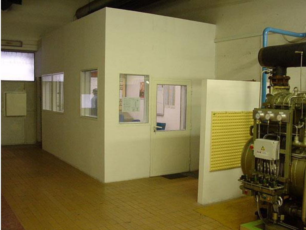
Slika 15. Primjer zvučno izolirane kontrolne sobe
