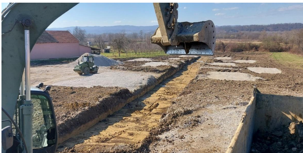
Slika 15. Priprema zemljišta za postavljanje kontejnerskog naselja nakon razornog potresa u Petrinji
