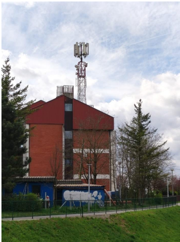
Slika 2. Antenski stup na krovu građevine
