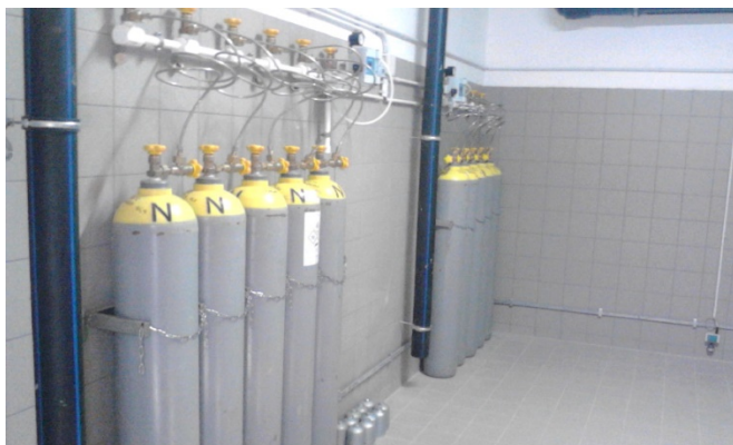
Slika 9. Skladištenje plinskog klora
