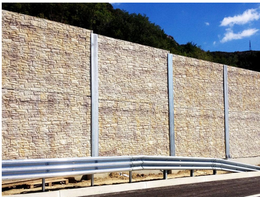
Slika 14 Zid za zaštitu od buke
