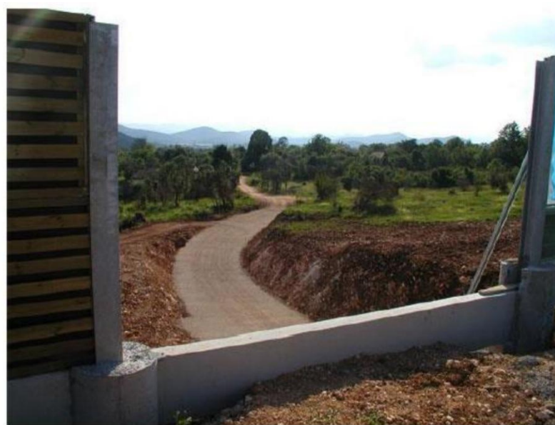
Slika 21 čelični profili i temelji profila
