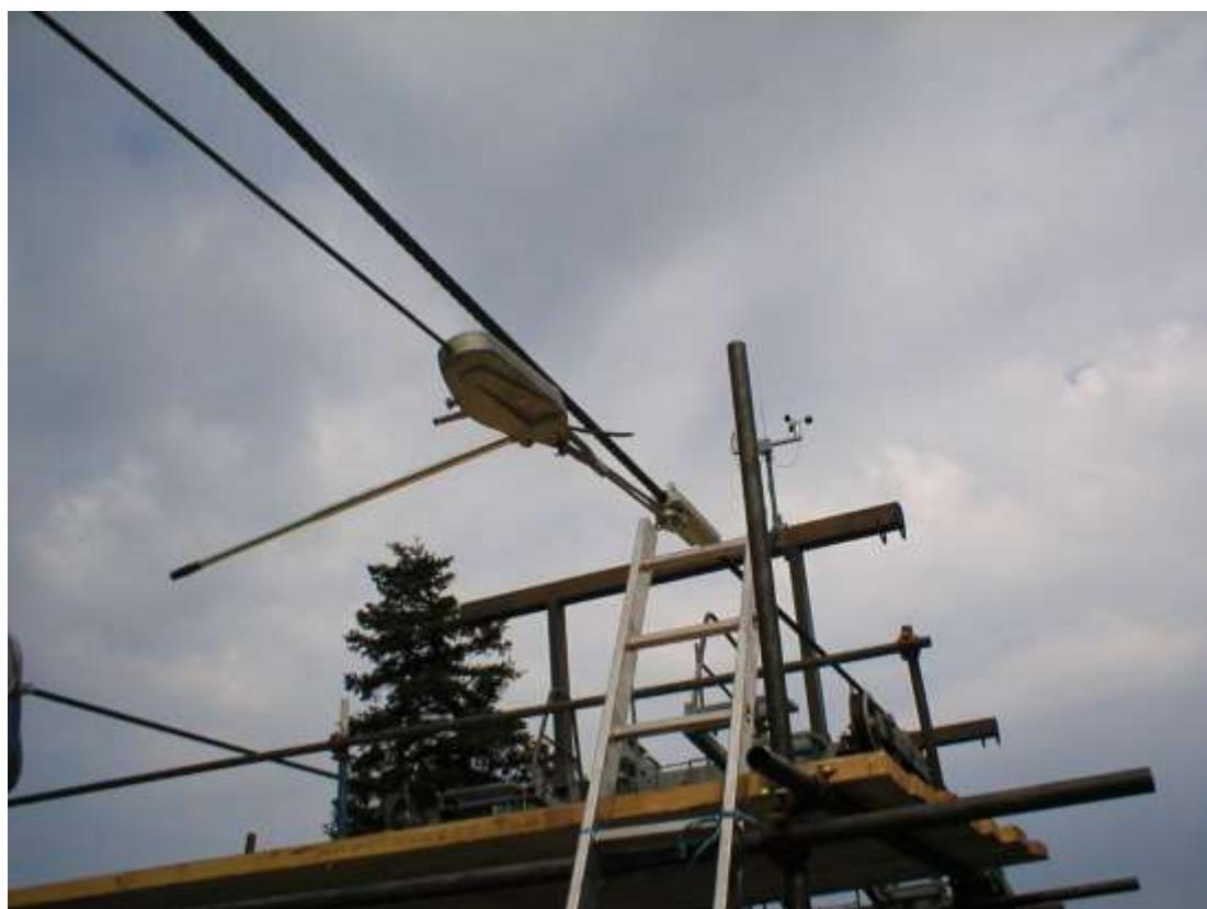
*Slika 33 Horizontalna potezna naprava (tirfor)*
