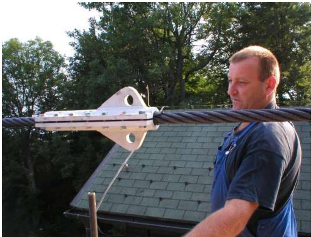
Slika 30 Dvodjelna naprava za potezanje
