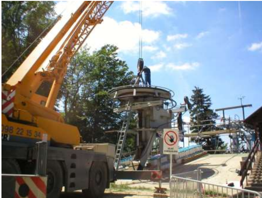
Slika 36. Skidanje kape pogonskog kotača
