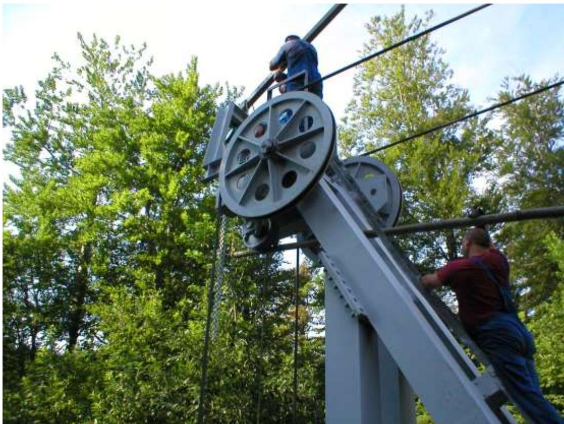
*Slika 19 Montaža naprave za podizanje protuutega (1)*
