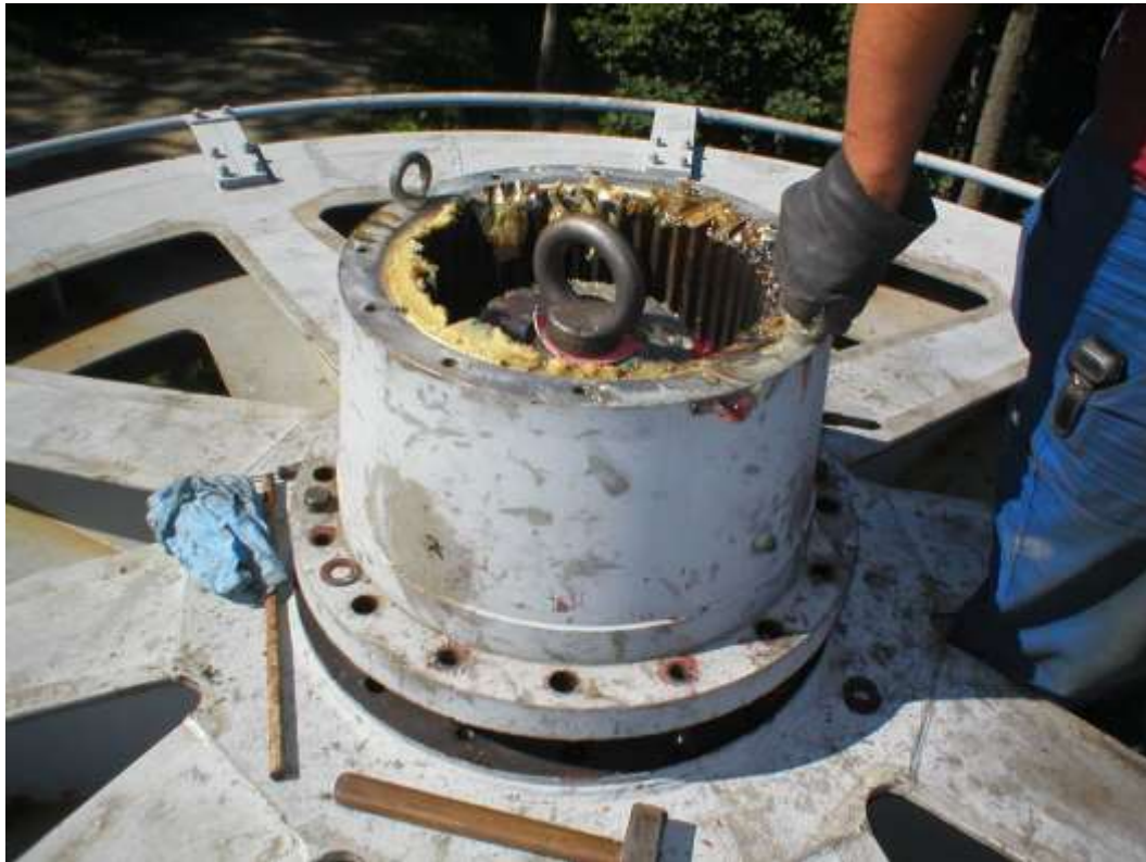
Slika 38 Podizanje dvodijelnog vratila (2)
