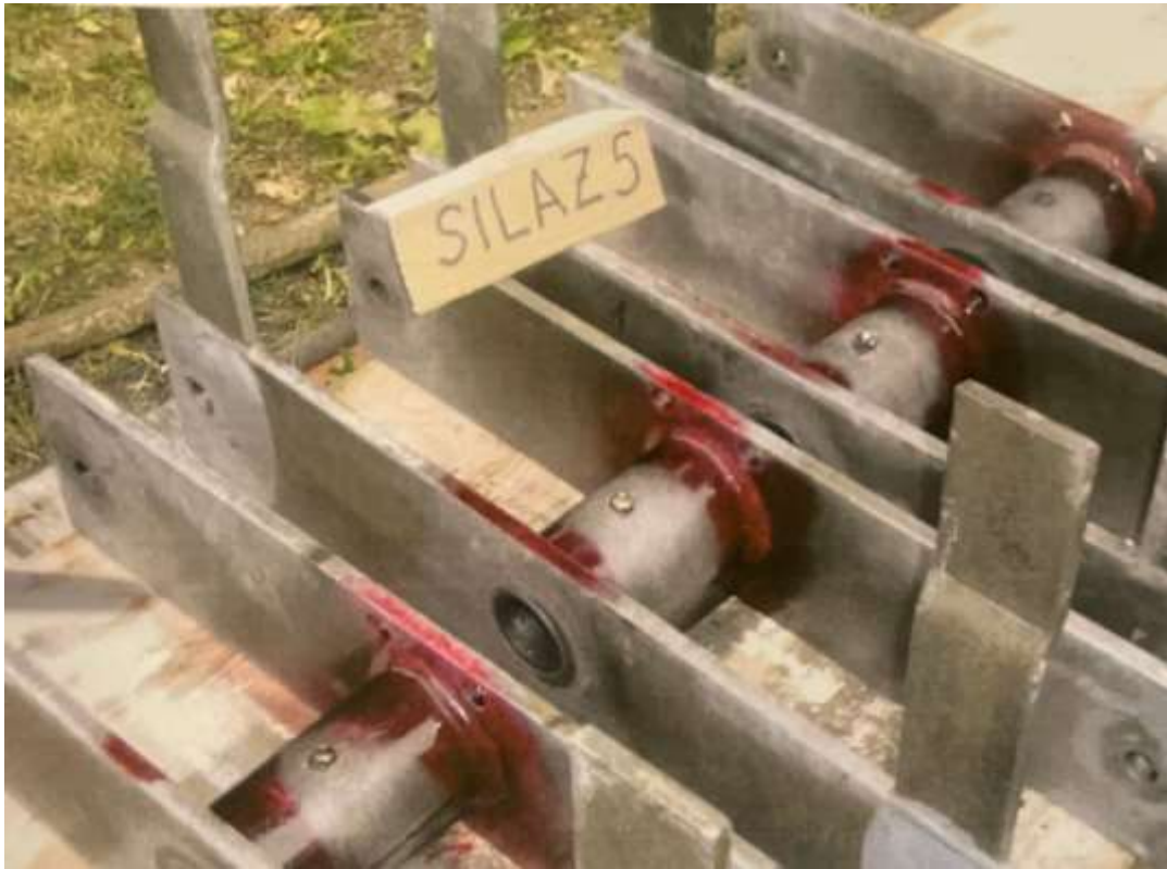
Slika 54 ispitivanje penetrantima podkonstrukcije velike i male vage (1)
