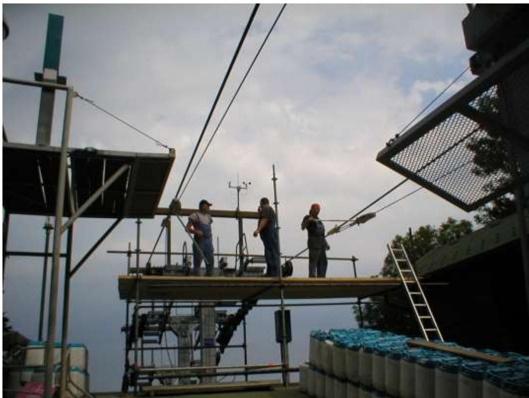
*Slika 32 Montaža dvodjelne naprave za potezanje (2)*
