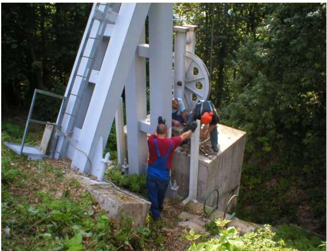
Slika 21 Montaža naprave za podizanje protuutega (3)
