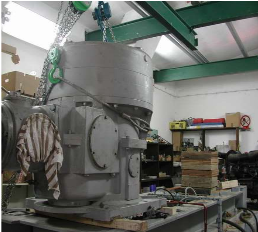
Slika 41 Demontažni postupak u podzemnoj strojarnici (1)
