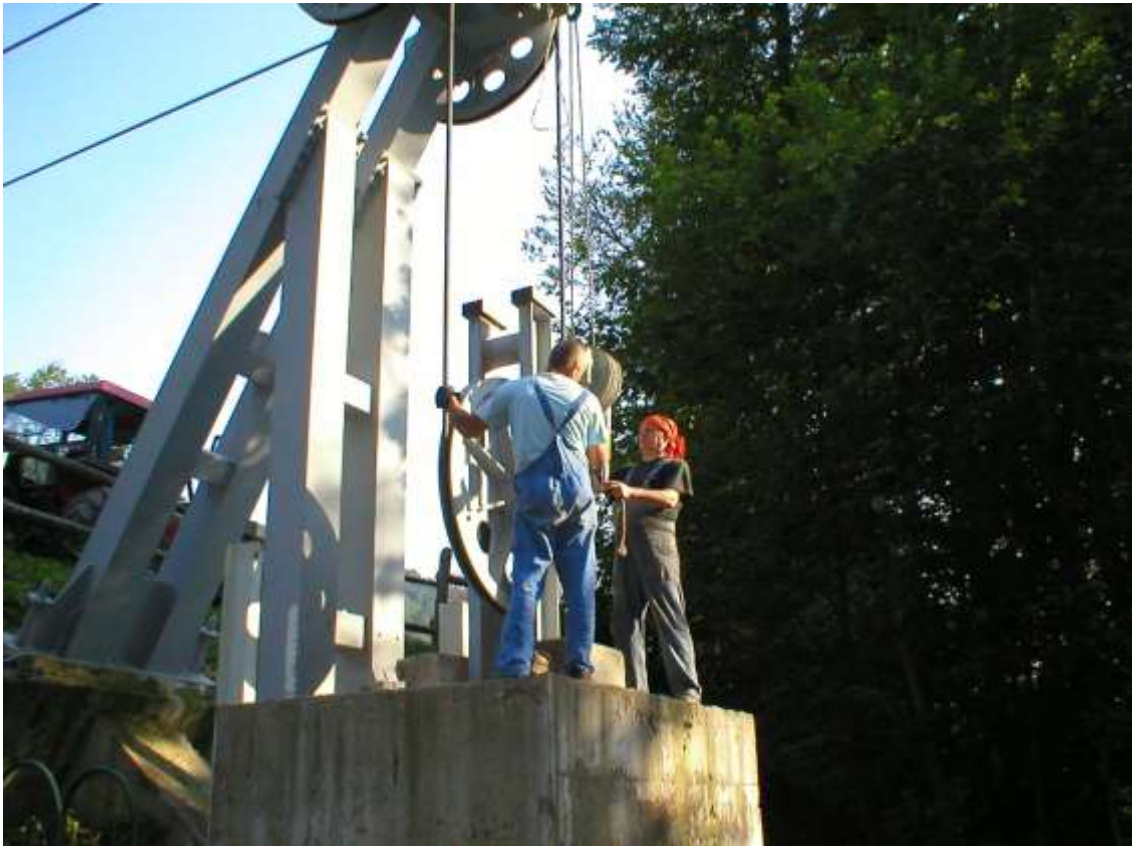
Slika 22 Montaža naprave za podizanje protuutega (4)
