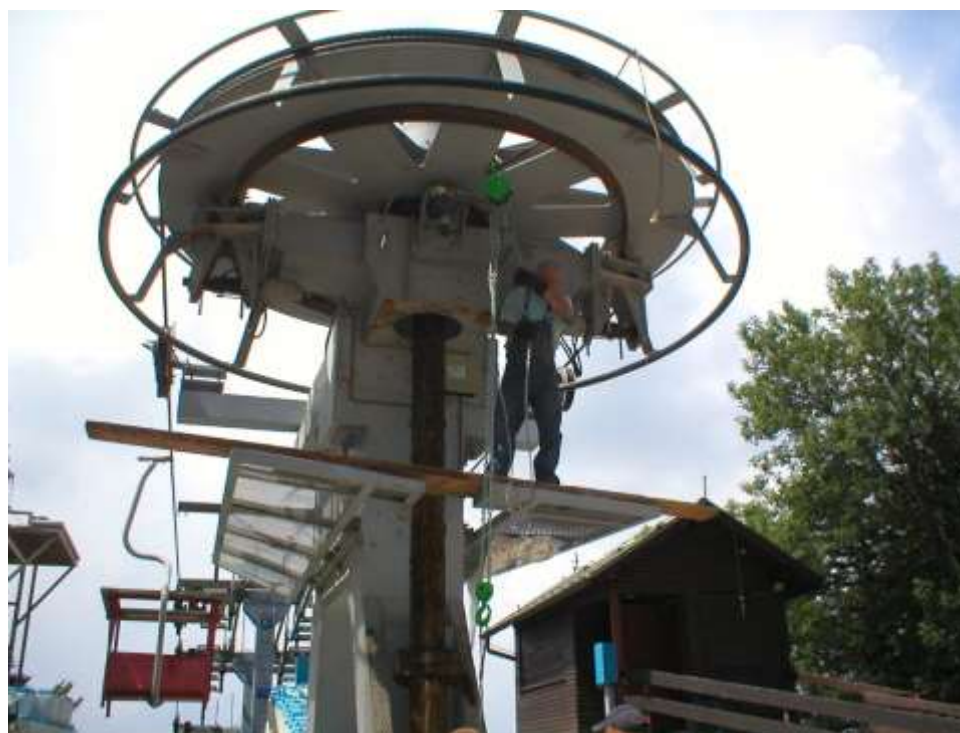
Slika 26 Montaža naprave za preuzimanje užeta (2)
