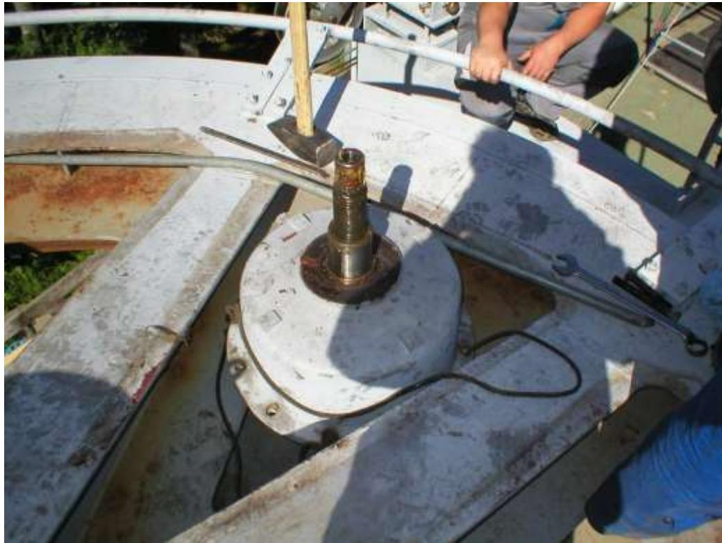
Slika 39 Podizanje dvodijelnog vratila (3)
