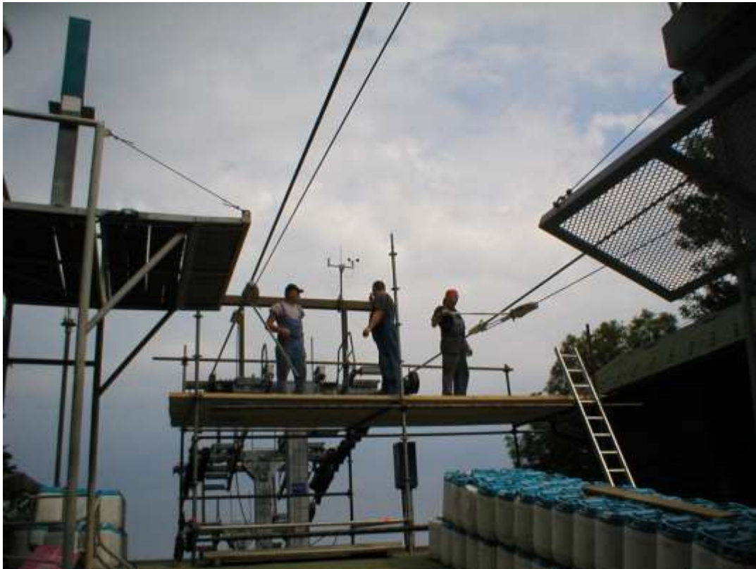
Slika 32 Montaža dvodjelne naprave za potezanje (2)
