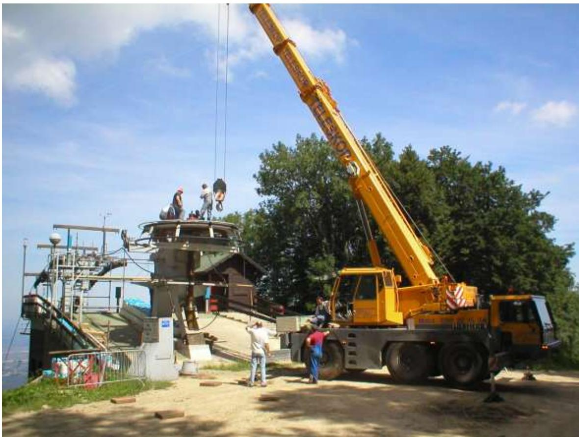
Slika 40 Podizanje dvodijelnog vratila (4)
