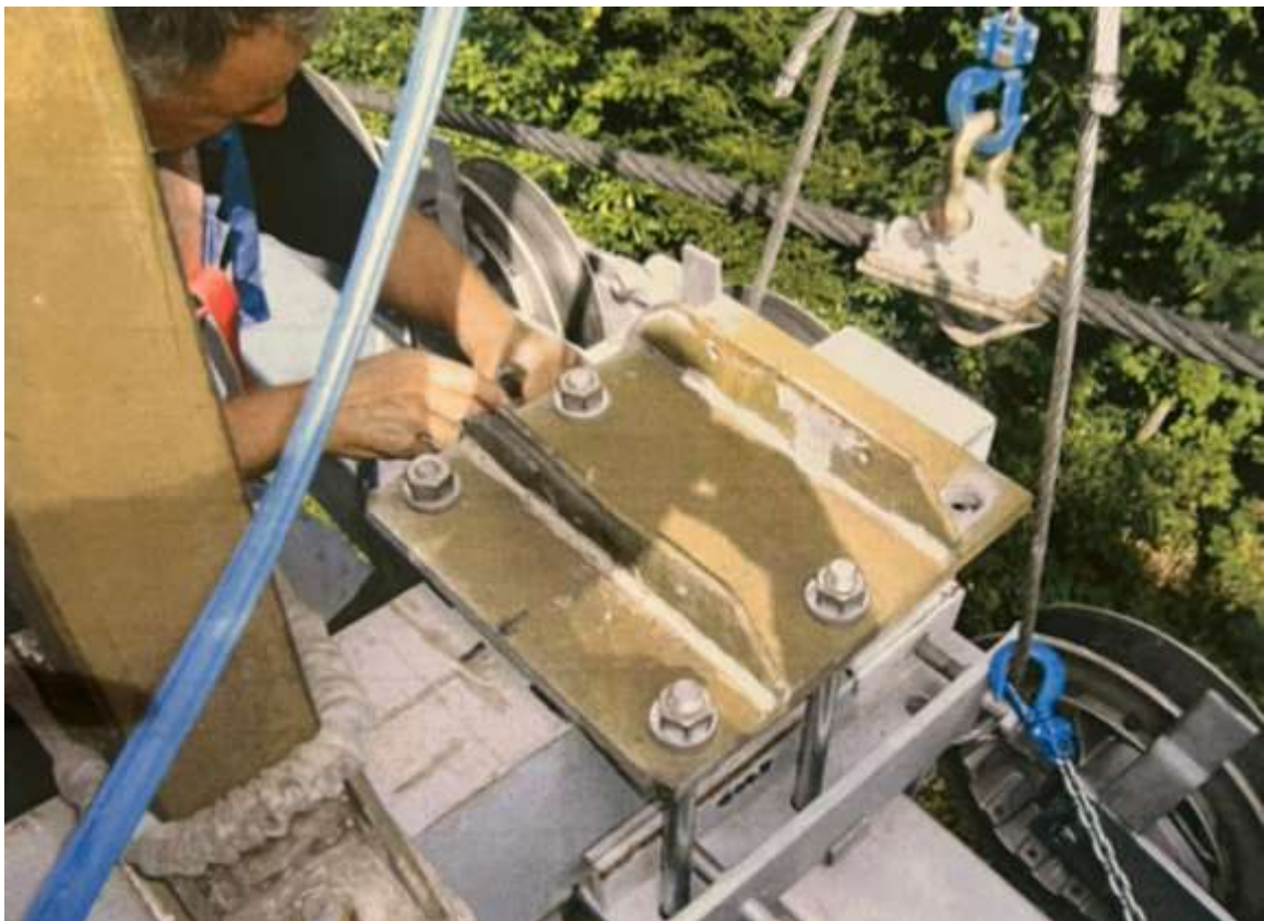
Slika 48 Demontaža baterijskog sklopa (2)
