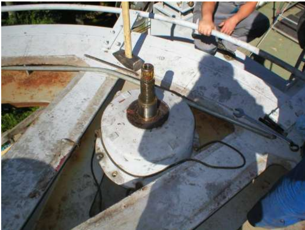
Slika 39 Podizanje dvodijelnog vratila (3)
