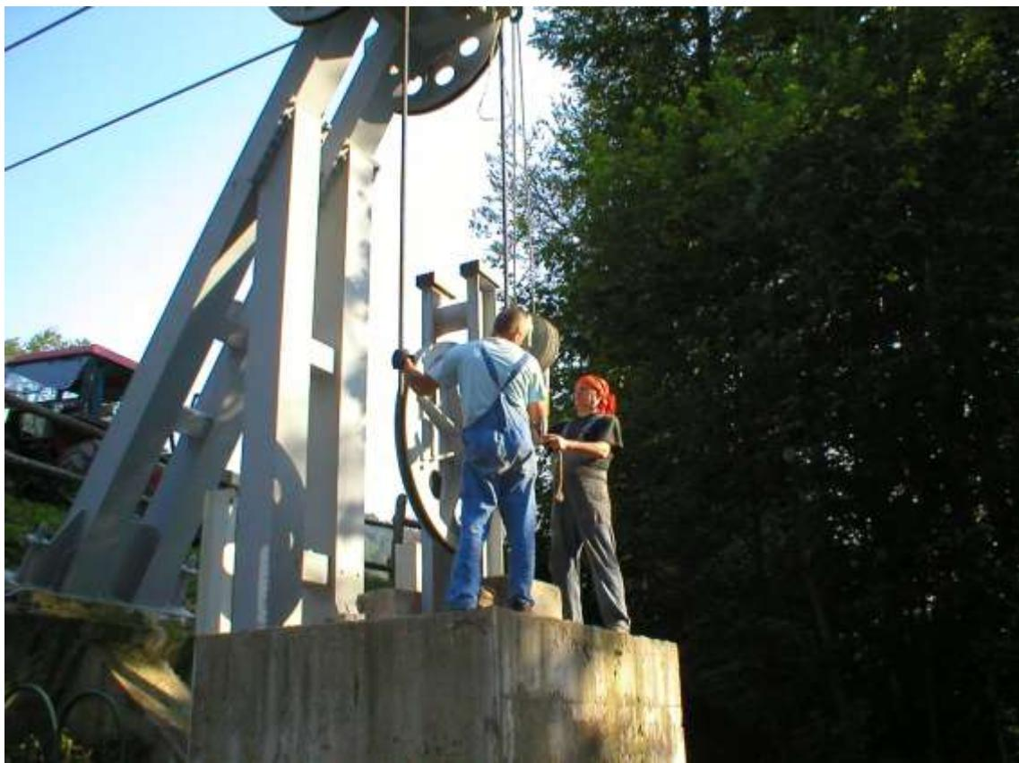
*Slika 22 Montaža naprave za podizanje protuutega (4)*
