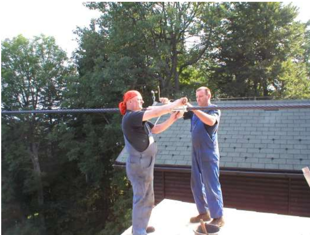
Slika 31 montaža dvodjelne naprave za potezanje (1)
