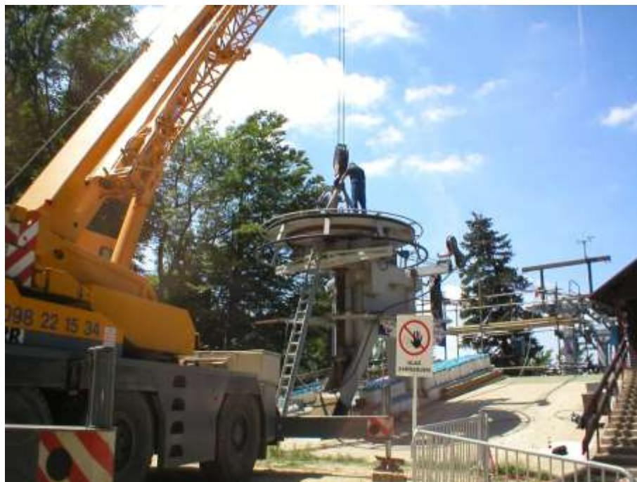
*Slika 36. Skidanje kape pogonskog kotača*
