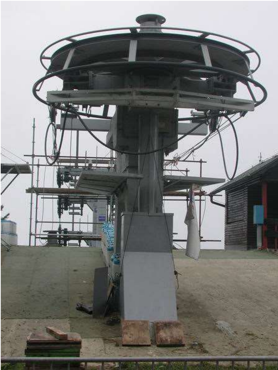
Slika 35 Uže preuzeto na pomočnu napravu
