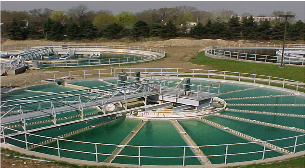
Slika 13. Bazeni za biološko pročišćavanje otpadnih voda
