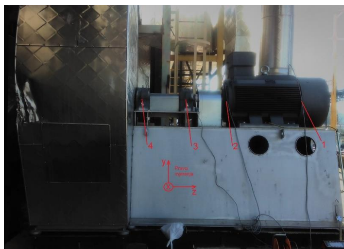
Slika 36. Slika mjernih mjesta ventilatorskih sistema ; Izvorno autor
