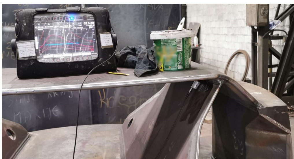
Slika 66. Neprihvatljiva indikacija na spoju dvaju „ojačanja“
