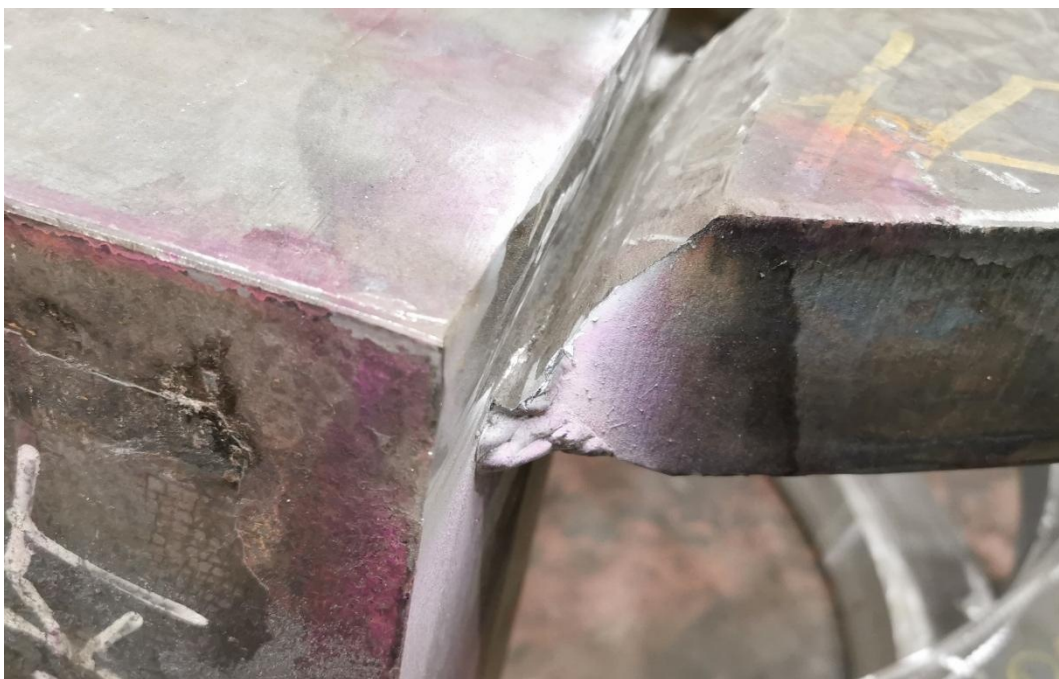
Slika 46. Izgled spoja nakon penetrantskog ispitivanja i brušenja
