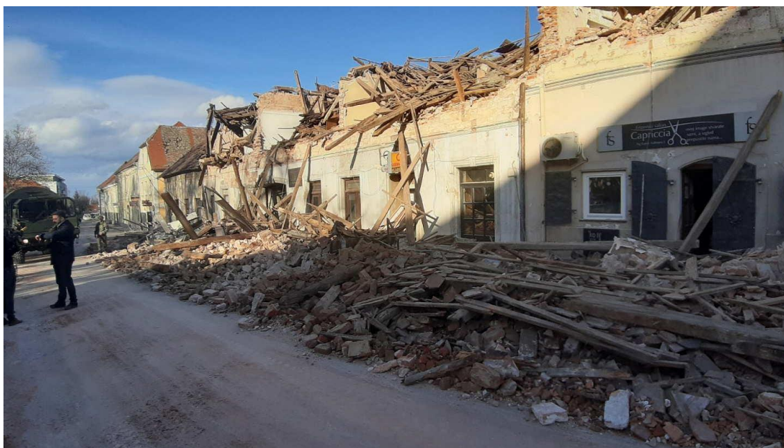
Slika 5. Građevine koje su se srušile na prometnicu [5]
