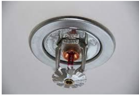
Slika 8. Sprinkler mlaznica [12]
