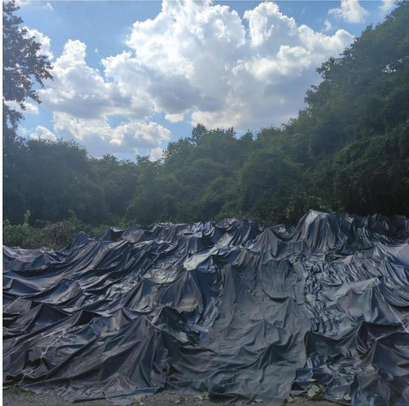
Slika 10. Prekrivanje geotekstilom (Jagarinec B., 2021)
