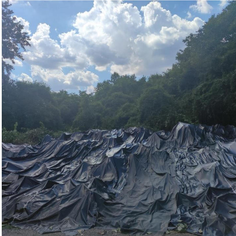
Slika 10. Prekrivanje geotekstilom (Jagarinec B., 2021)
