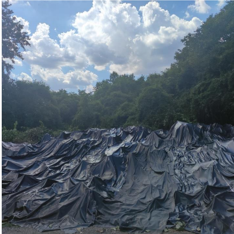
Slika 10. Prekrivanje geotekstilom (Jagarinec B., 2021)
