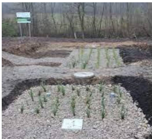
SLIKA 7. Bazen sa šljunčanom ispunom i biljkama [14]
