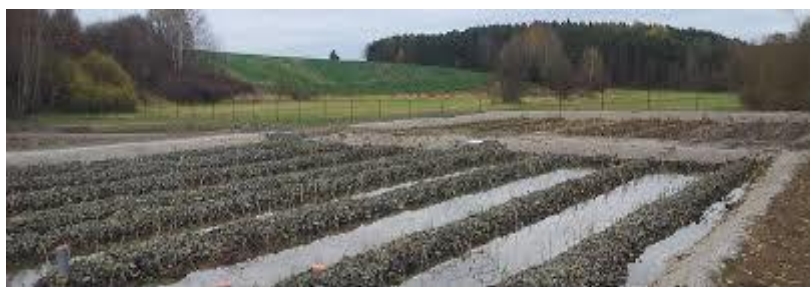
SLIKA 2. Međusobno povezani bazeni kod površinskih biljnih uređaja [10]
