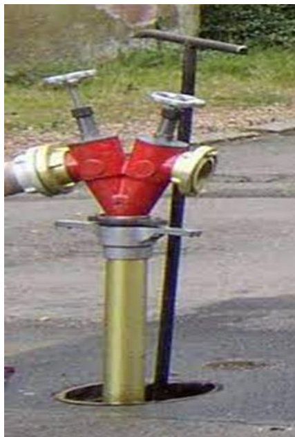
Slika 26. Hidrantski nastavak spojen na podzemni hidrant[19]
