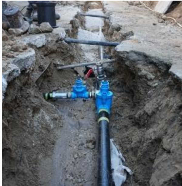
Slika 20. Cjevovod za dopremanje vode[19]
