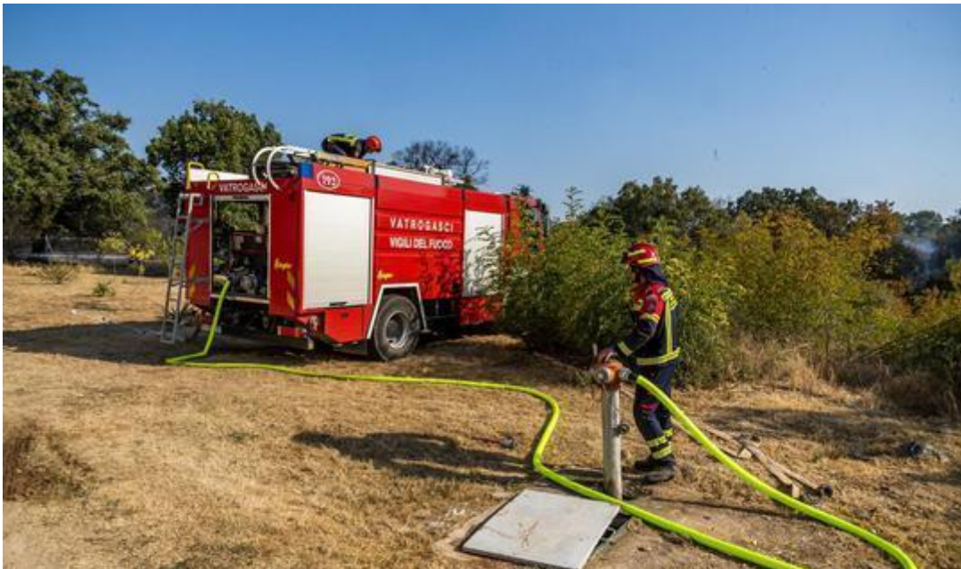
Slika 27. Vatrogasno vozilo priključeno na podzemni hidrant[24]
