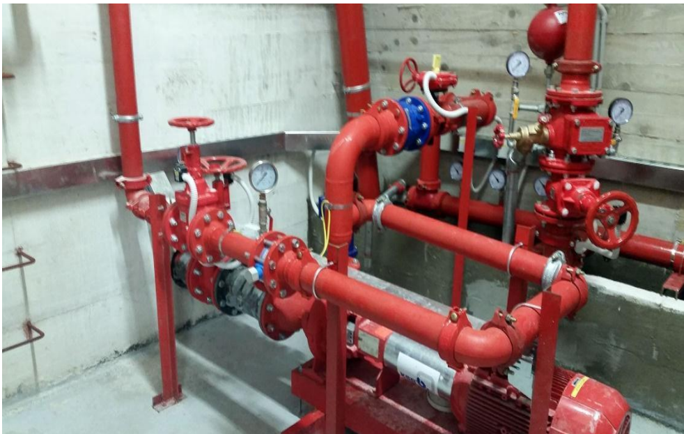
Slika 22. Prostorija sa uređajem za povišenje tlaka [14]
