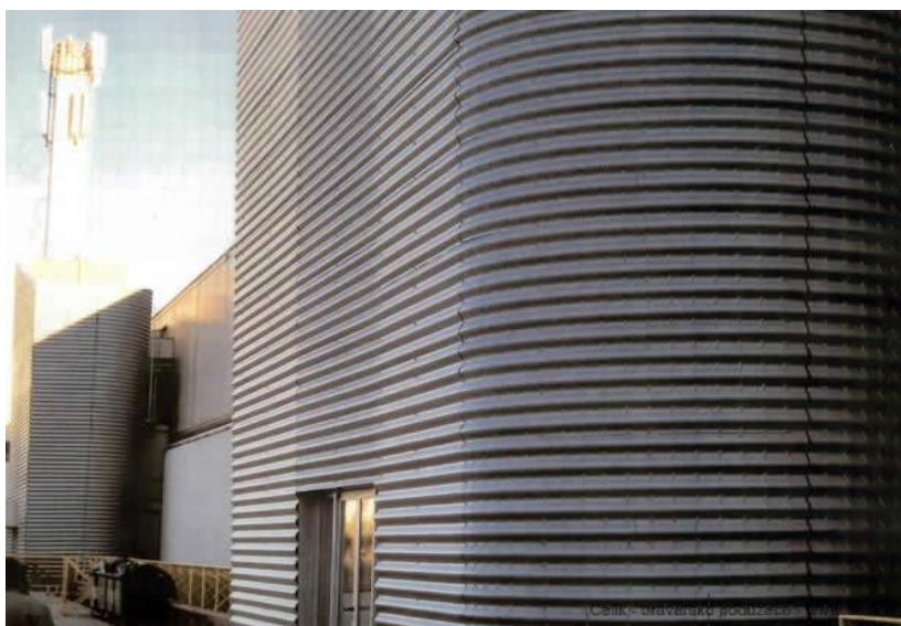
Slika 3. Aluminijska fasada [3]
