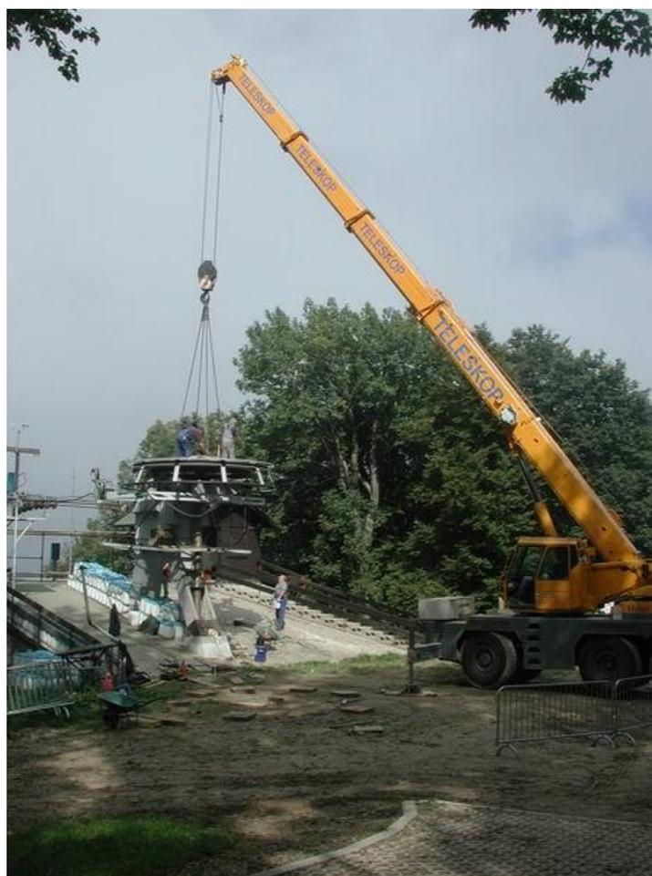
Slika 49. Montaža pogonskog okretnog kotača [7]
