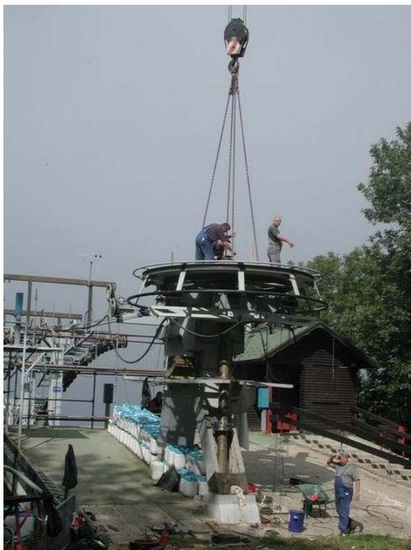
Slika 50. Montaža pogonskog okretnog kotača (1) [7]
