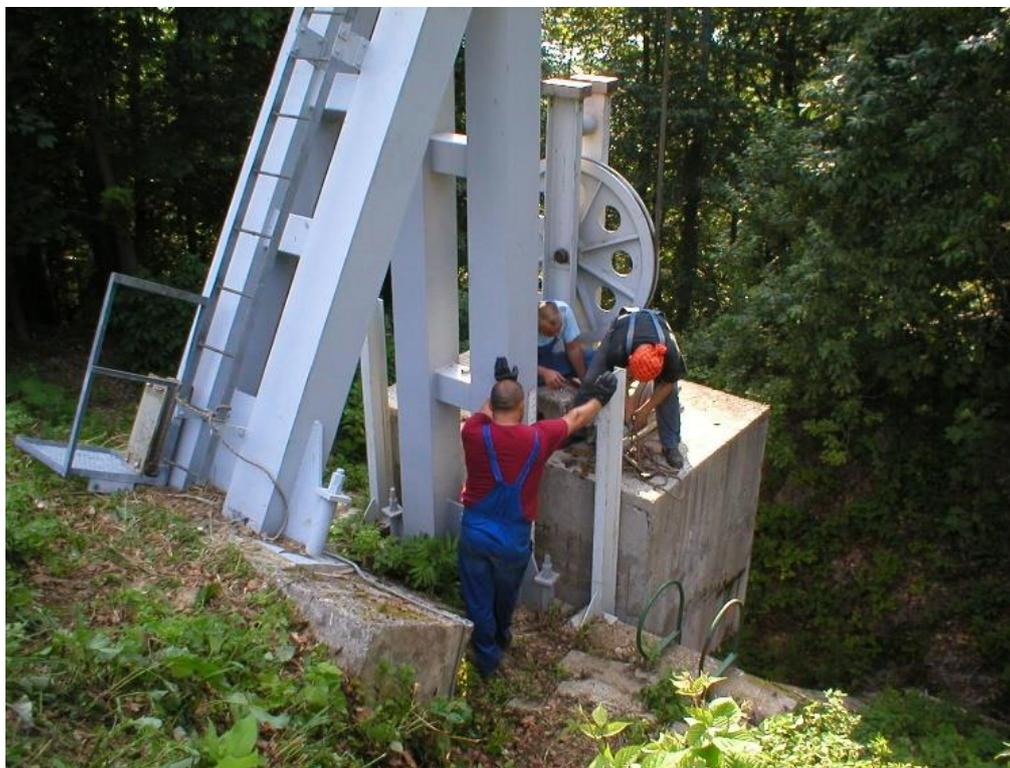
Slika 25. Montaža naprave za podizanje protuutega (2) [7]
