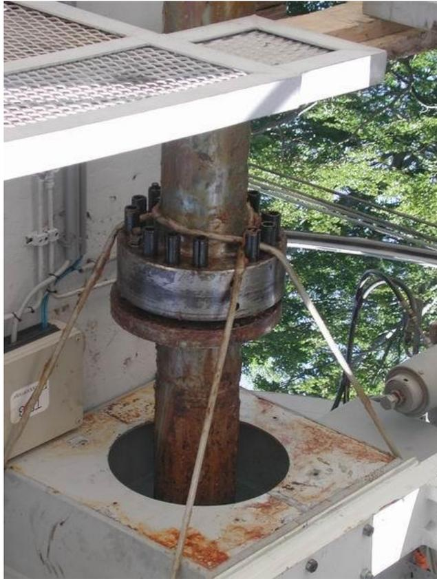
Slika 40. Demontaža spojnih vijaka [7]
