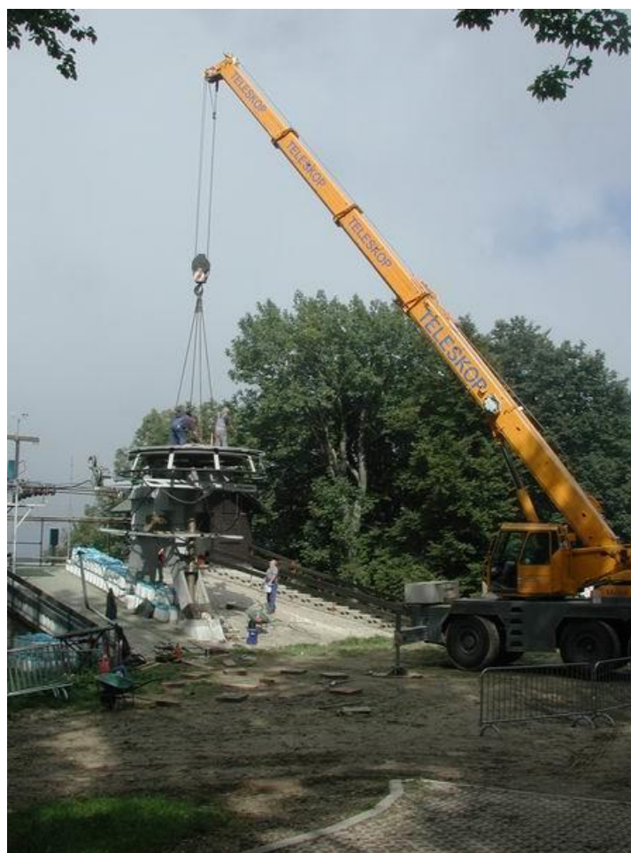
Slika 49. Montaža pogonskog okretnog kotača [7]
