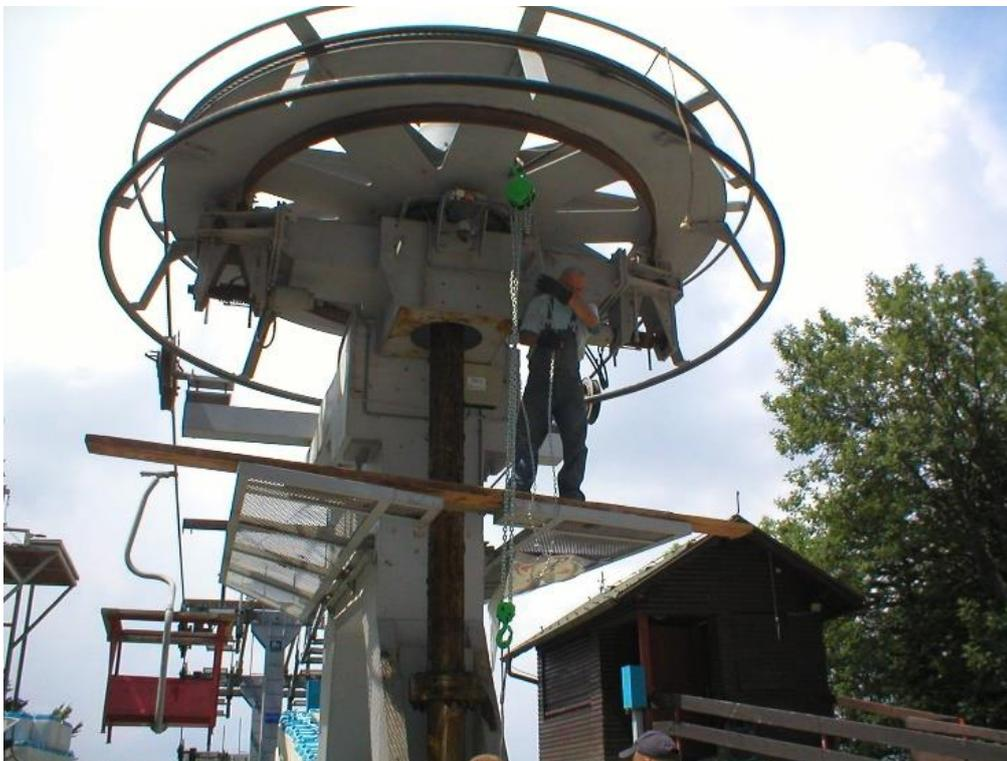
Slika 28. Montaža naprave za preuzimanje nosivog užeta s pogonskog kotača (2) [7]
