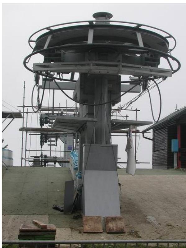
Slika 51. Montiran pogonski okretni kotač [7]
