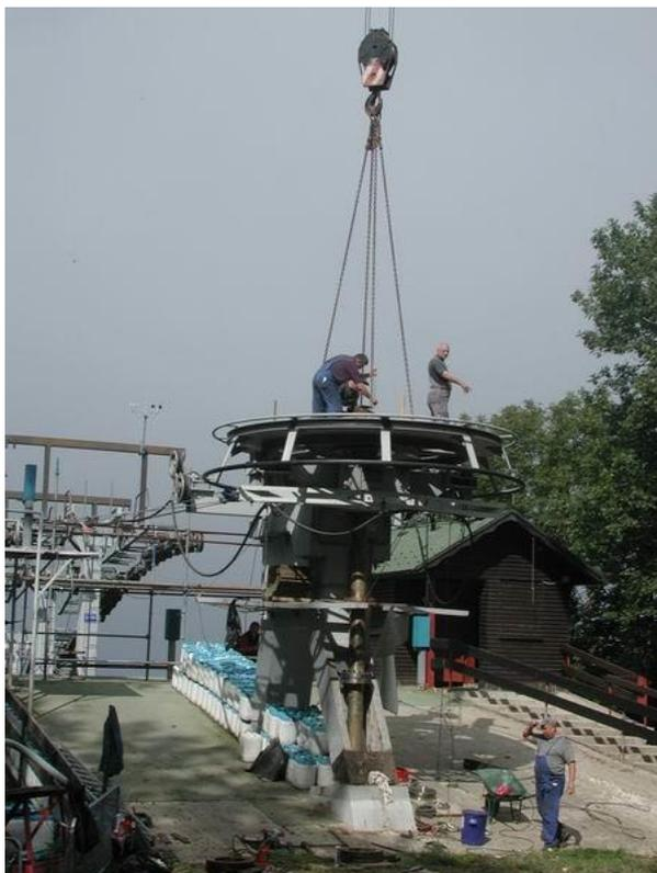
Slika 50. Montaža pogonskog okretnog kotača (1) [7]
