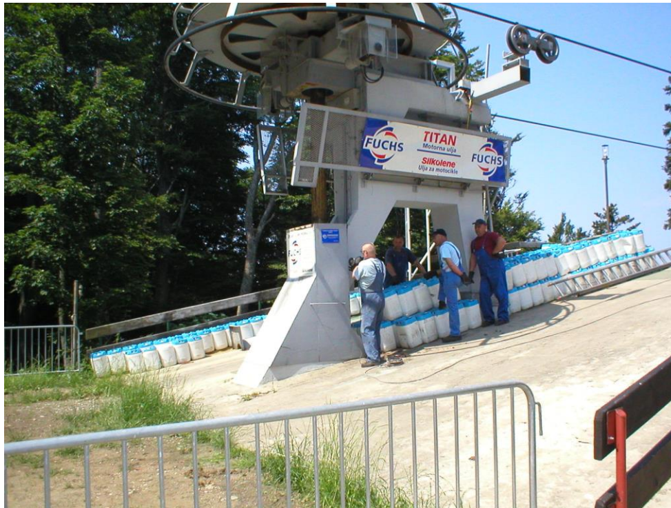
Slika 29. Oplata dvodijelnog vratila prije demontaže [7]
