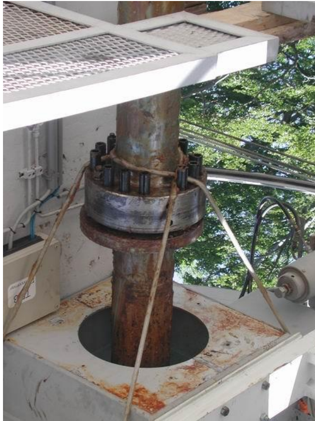
Slika 40. Demontaža spojnih vijaka [7]
