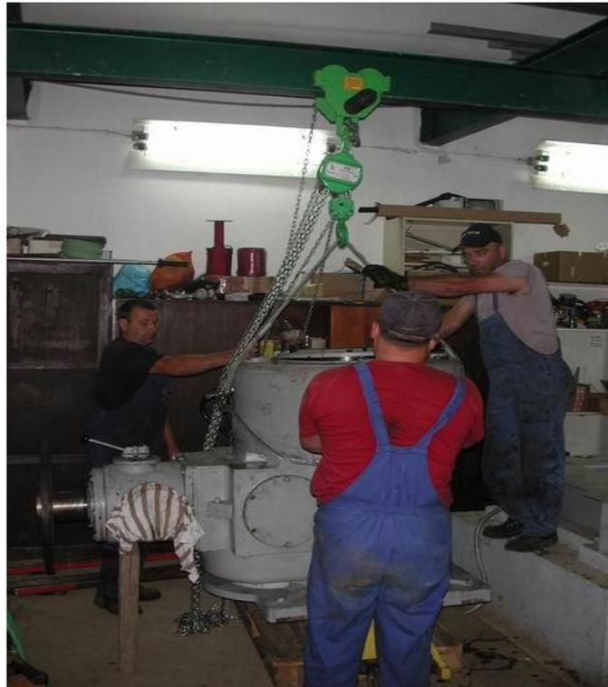
Slika 37. Demontaža reduktora [7]
