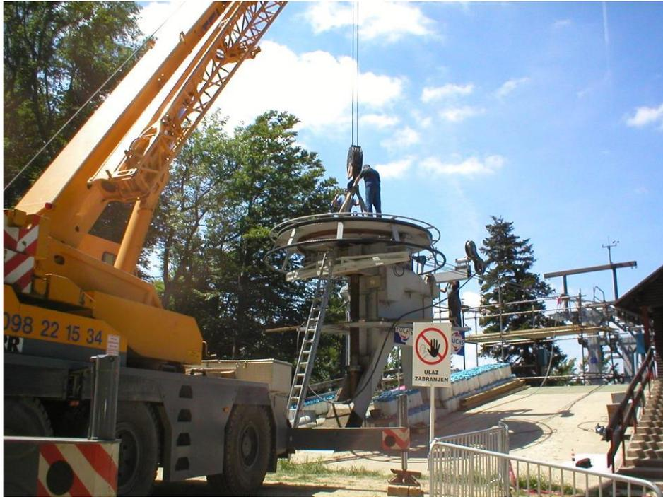
Slika 41. Podizanje vratila autodizalicom [7]
