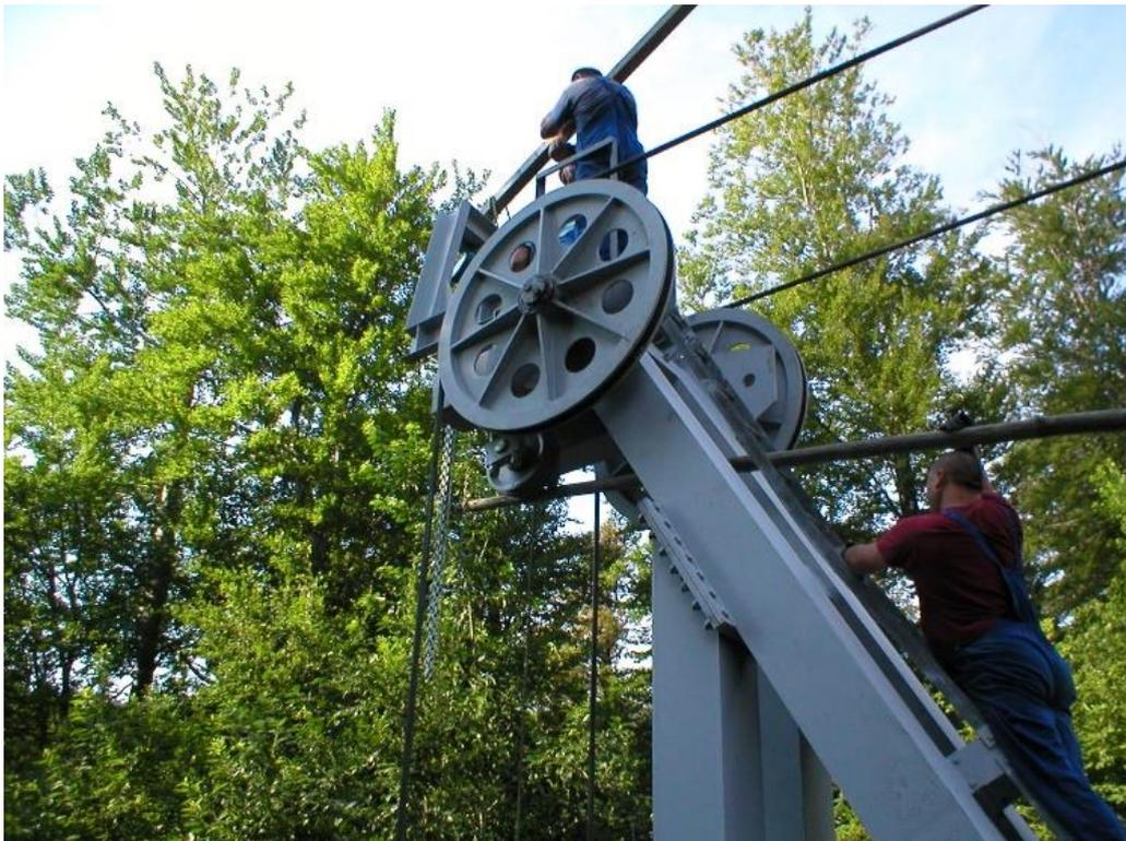
Slika 23. Montaža naprave za podizanje protuutega [7]
