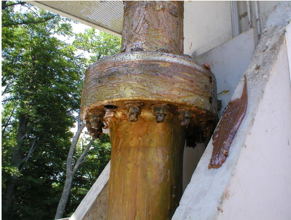
Slika 30. Dvodijelno vratilo nakon demontaže oplate [7]
