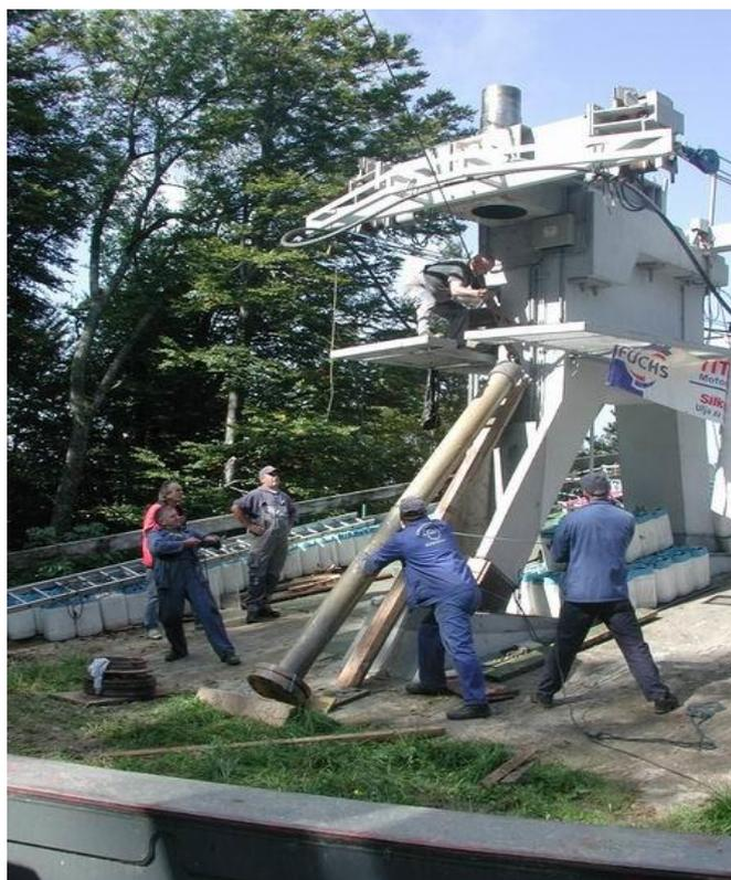
Slika 46. Montaža dvodijelnog vratila [7]
