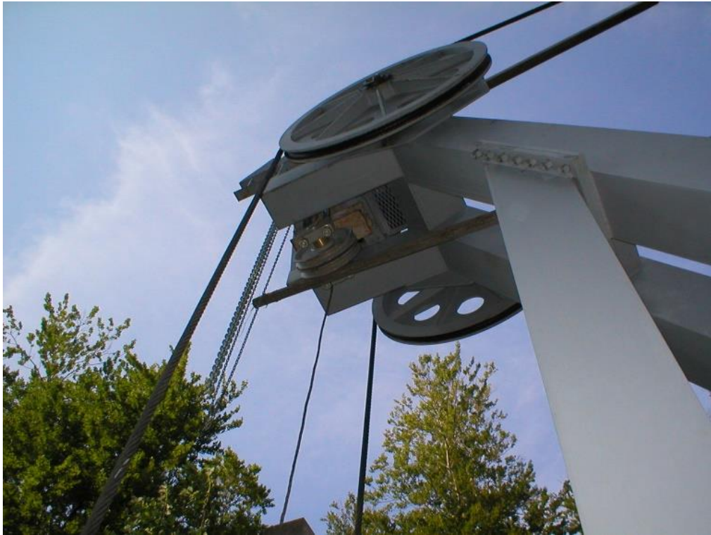
Slika 24. Montaža naprave za podizanje protuutega (1) [7]
