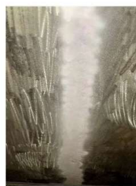
Slika 4. PT zavara između ploča brtvene stijene
