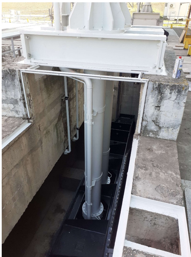
Slika 4.32 Montaža servomotora i zatvarača
