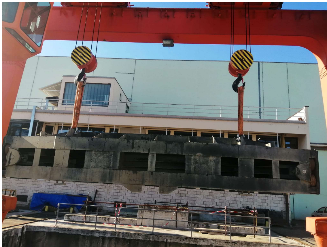
Slika 4.17 Izvlačenje segmenata zatvarača portalnom dizalicom
