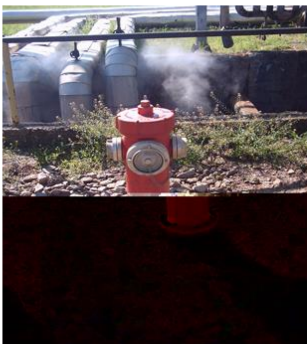
Slika 8: Nadzemni hidrant tipa „SILVANI“ [10] 10
