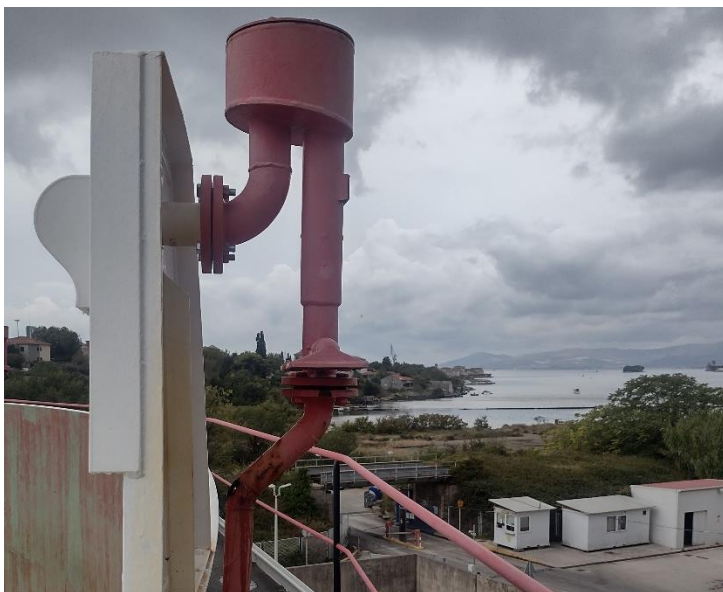
Sl. 9. Mlaznica za zračnu pjenu na spremniku s plivajućim krovom [Vlastita fotografija]
