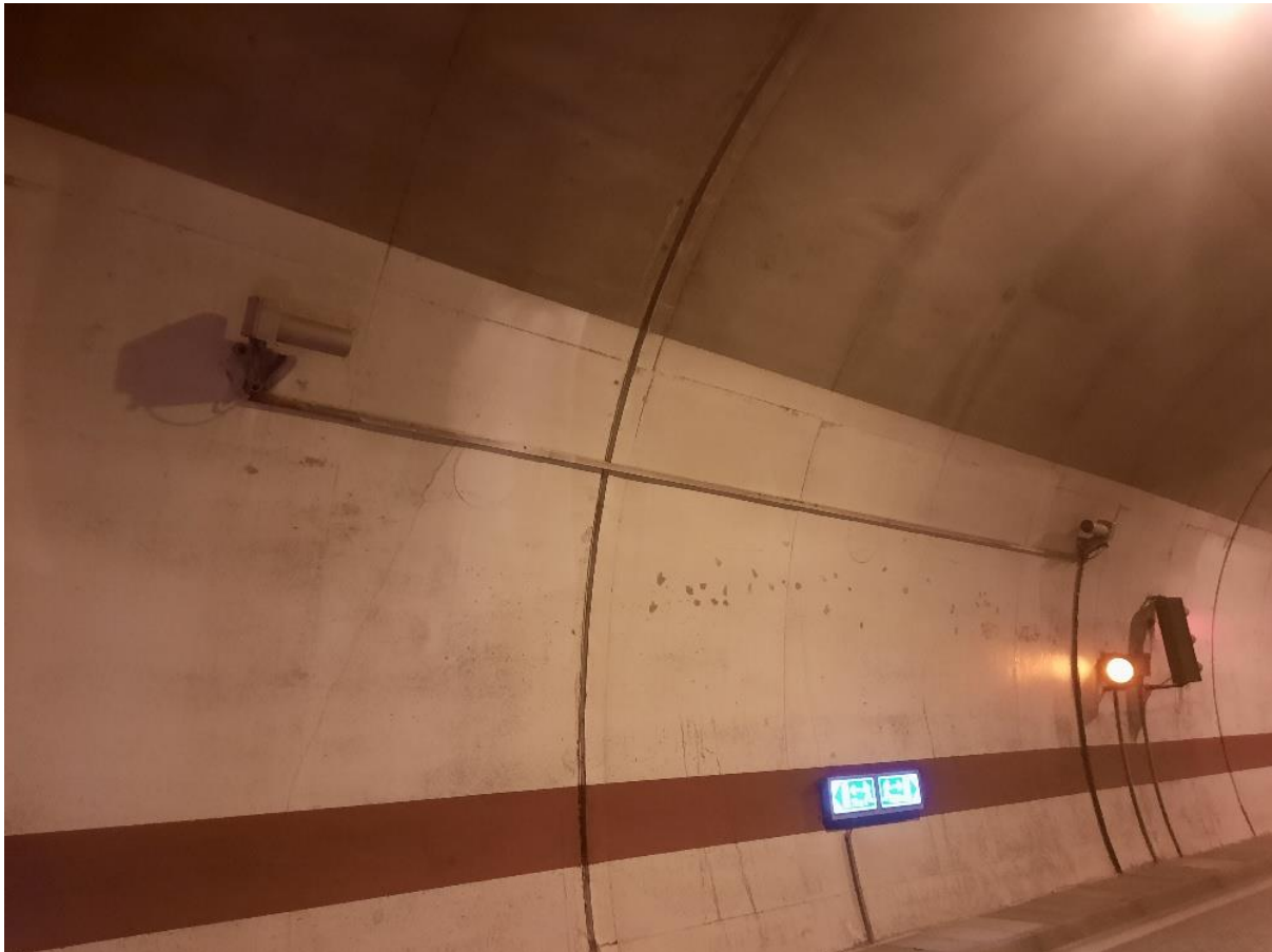
Slika 14. Senzori vidljivosti i CO (vlastiti izvor)
