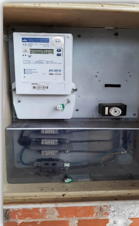
Slika 2. KPMO s digitalnim brojilom
