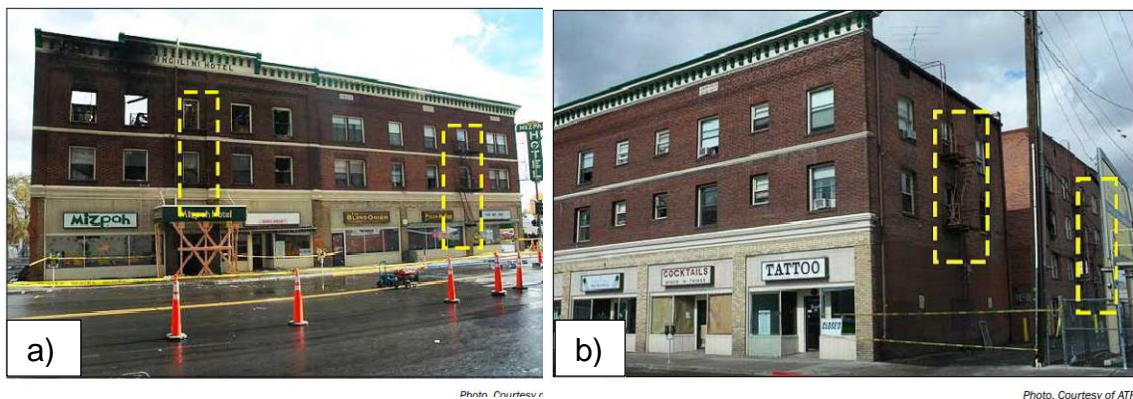
Slika 6. a) Prednje vanjsko požarno stubište b) Stražnje vanjsko požarno stubište [6]
