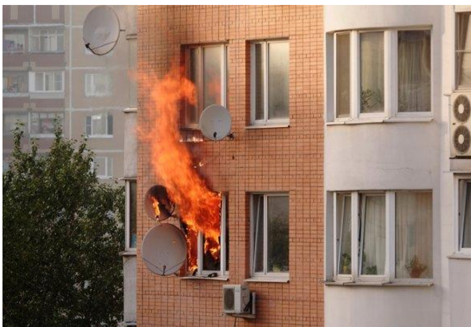
Sl. 3. Dizanje vrućih plinova i plamena po fasadi
