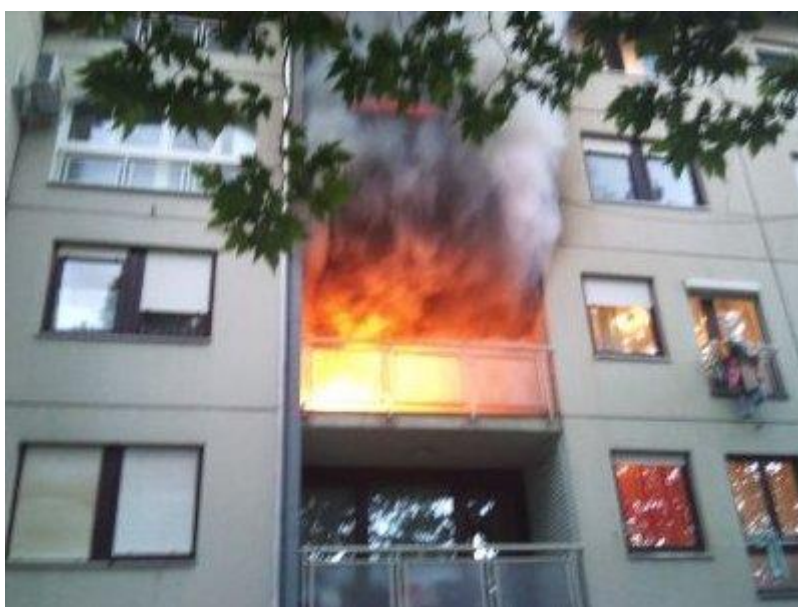
Sl.2. Širenje požara na etažu iznad
