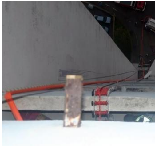
Sl.8. Postavljena vertikala v.t.
