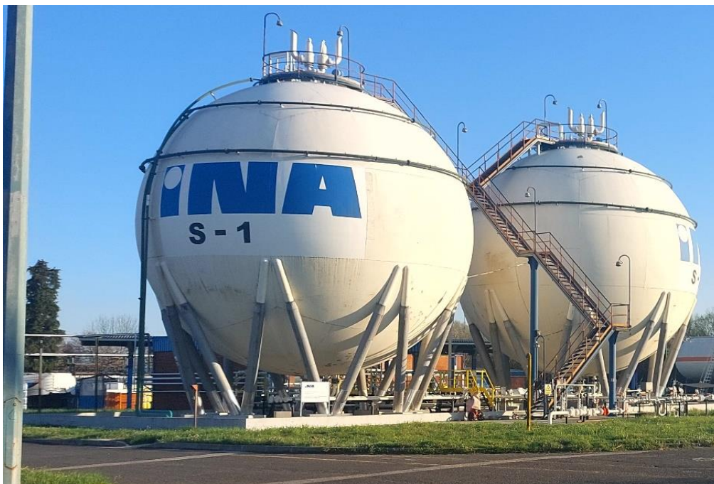
Slika 12. Kuglasti spremnik [8]
