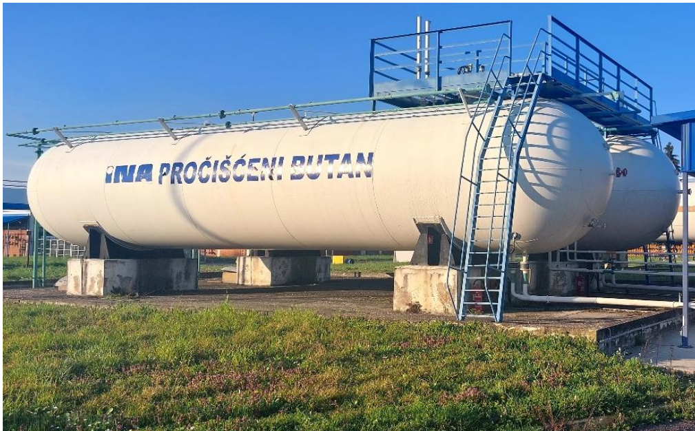
Slika 11. Horizontalni cilindrični spremnik [8]
