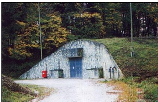
Slika 6. Skladišni objekt vrste U-20
